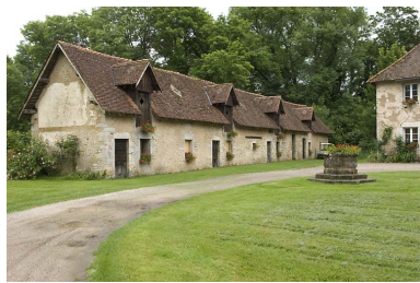
Logement ouvrier vu depuis le nord.
