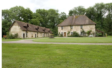
Logements ouvrier et patronal depuis le nord. Phot. Jérôme Mongreville IVR43_20087000544NUC2A
