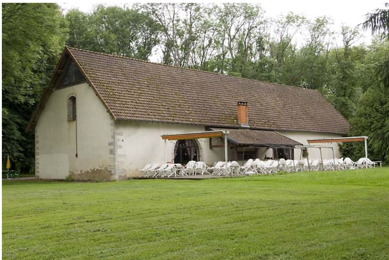
Ancienne halle à charbon depuis le sud.
