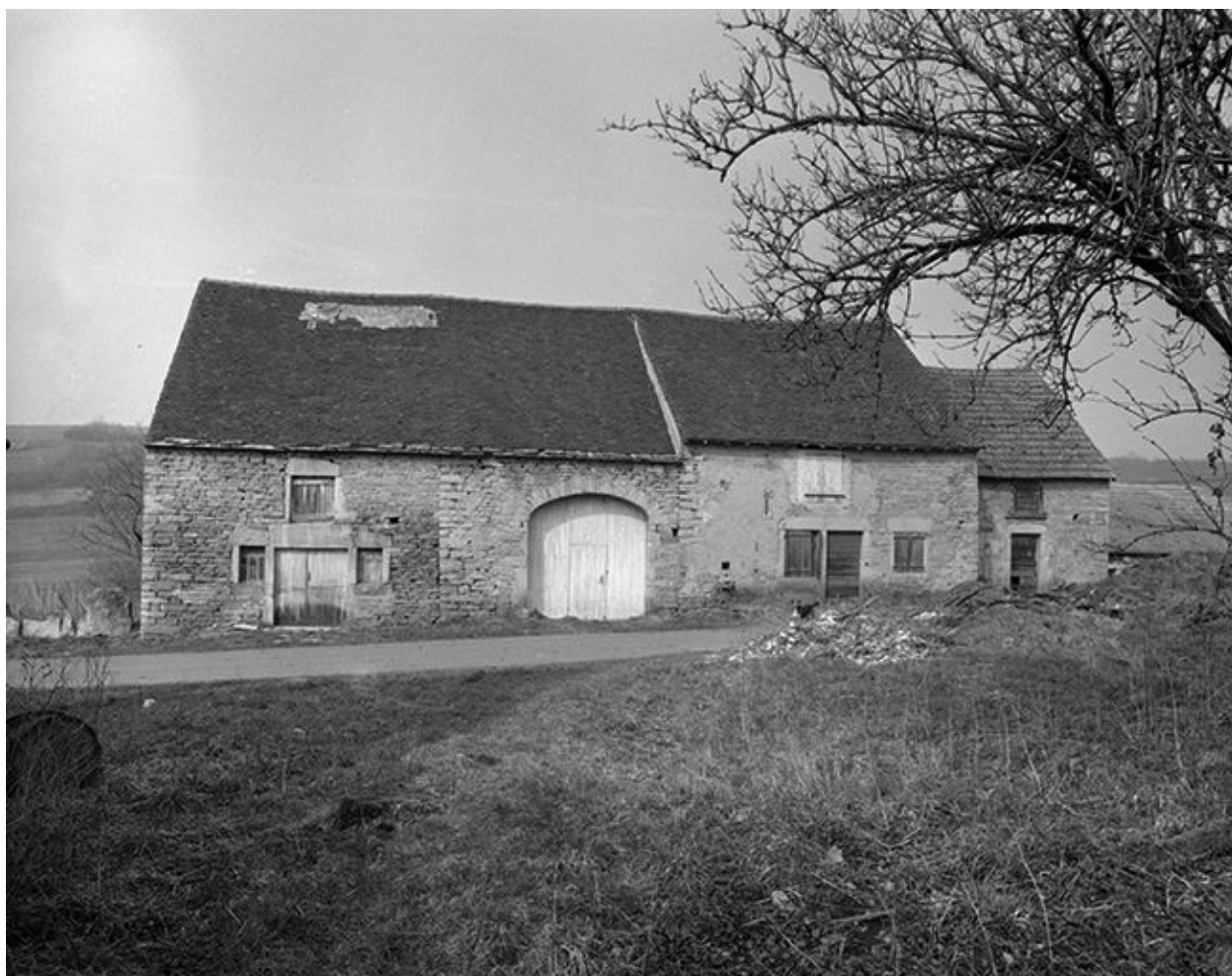
Ferme située rue de la Chapelle.
