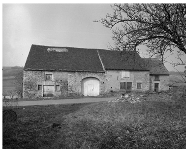
Ferme située rue de la Chapelle. Phot. Jérôme Mongreville IVR43_19853900082X
