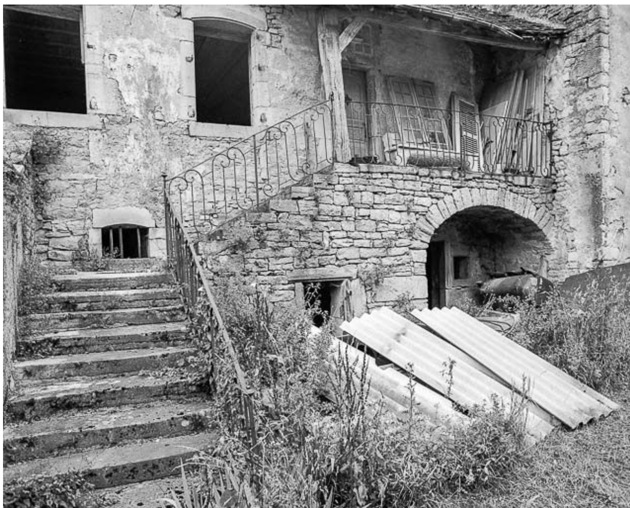
Détail de l'escalier.
