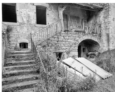
Détail de l'escalier. Phot. Yves Sancey IVR43_19843900241X
