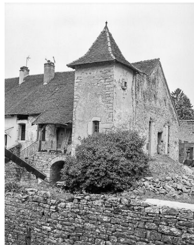
Vue de la tourelle. Phot. Yves Sancey IVR43_19843900240X
