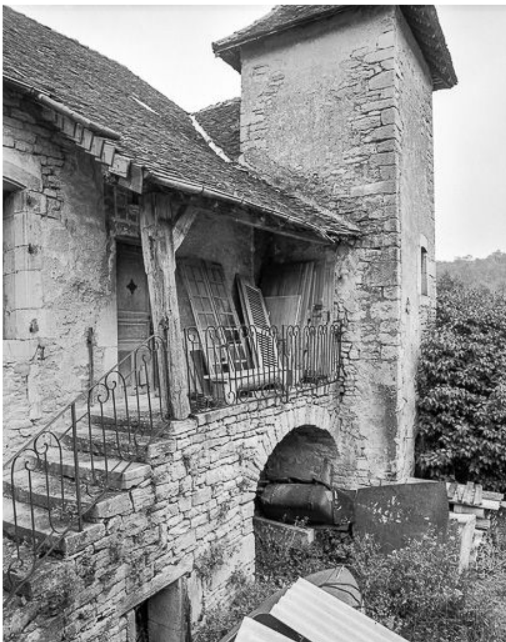
Auvent protégeant l'escalier.
