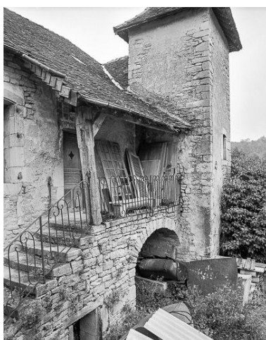
Auvent protégeant l'escalier. Phot. Yves Sancey IVR43_19843900242X
