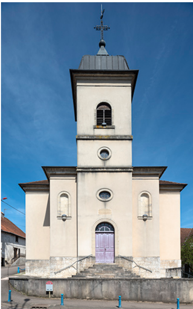
La façade antérieure de la chapelle.
