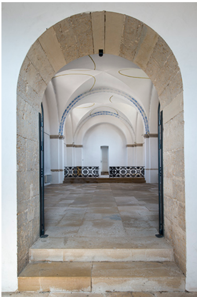
Vue générale depuis le porche.
