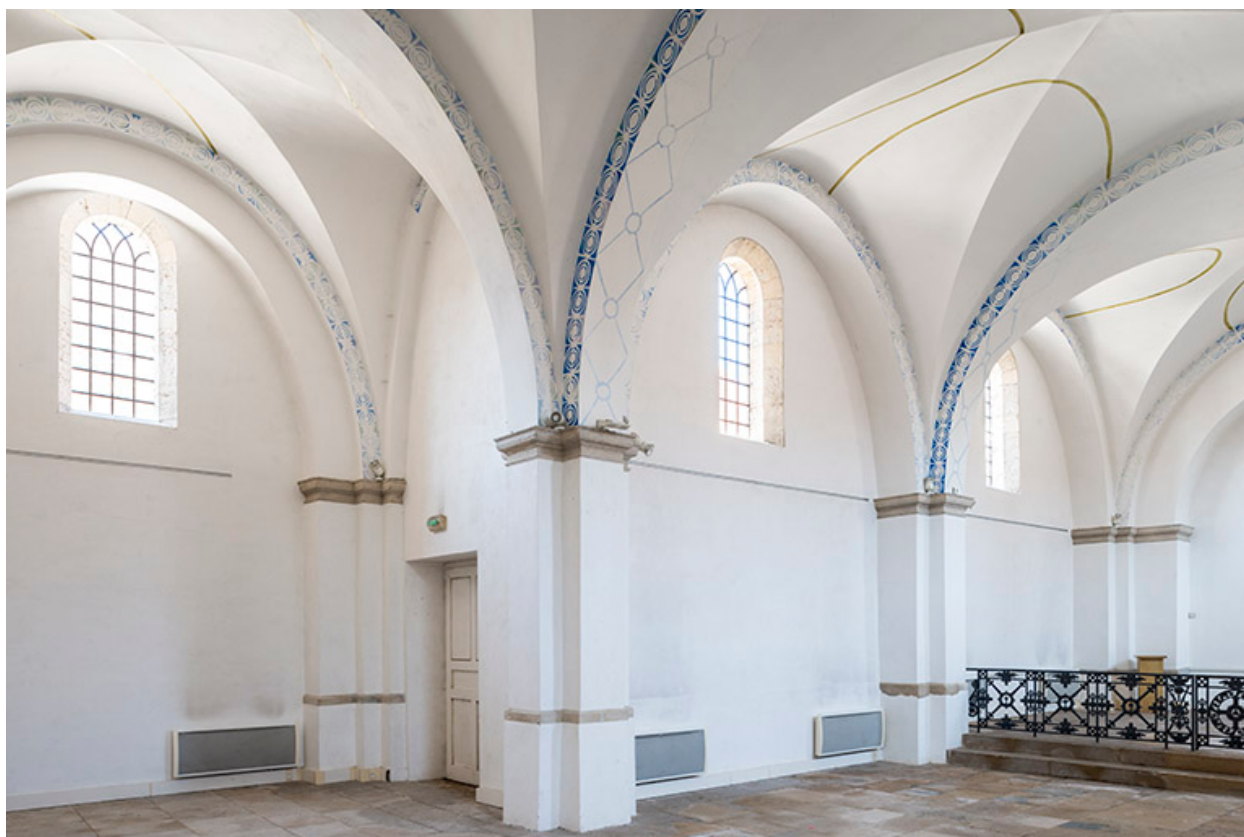
Le mur ouest de la nef.
