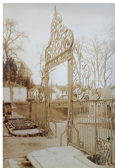
Vue de la grille avant sa dépose. Autr. H. Décez IVR43_20217000014NUC2A
