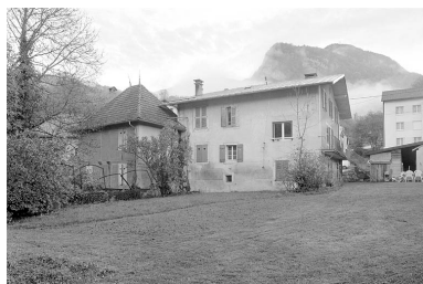
Façade postérieure de l'ensemble. Phot. Jérôme Mongreville IVR43_19963901634X
