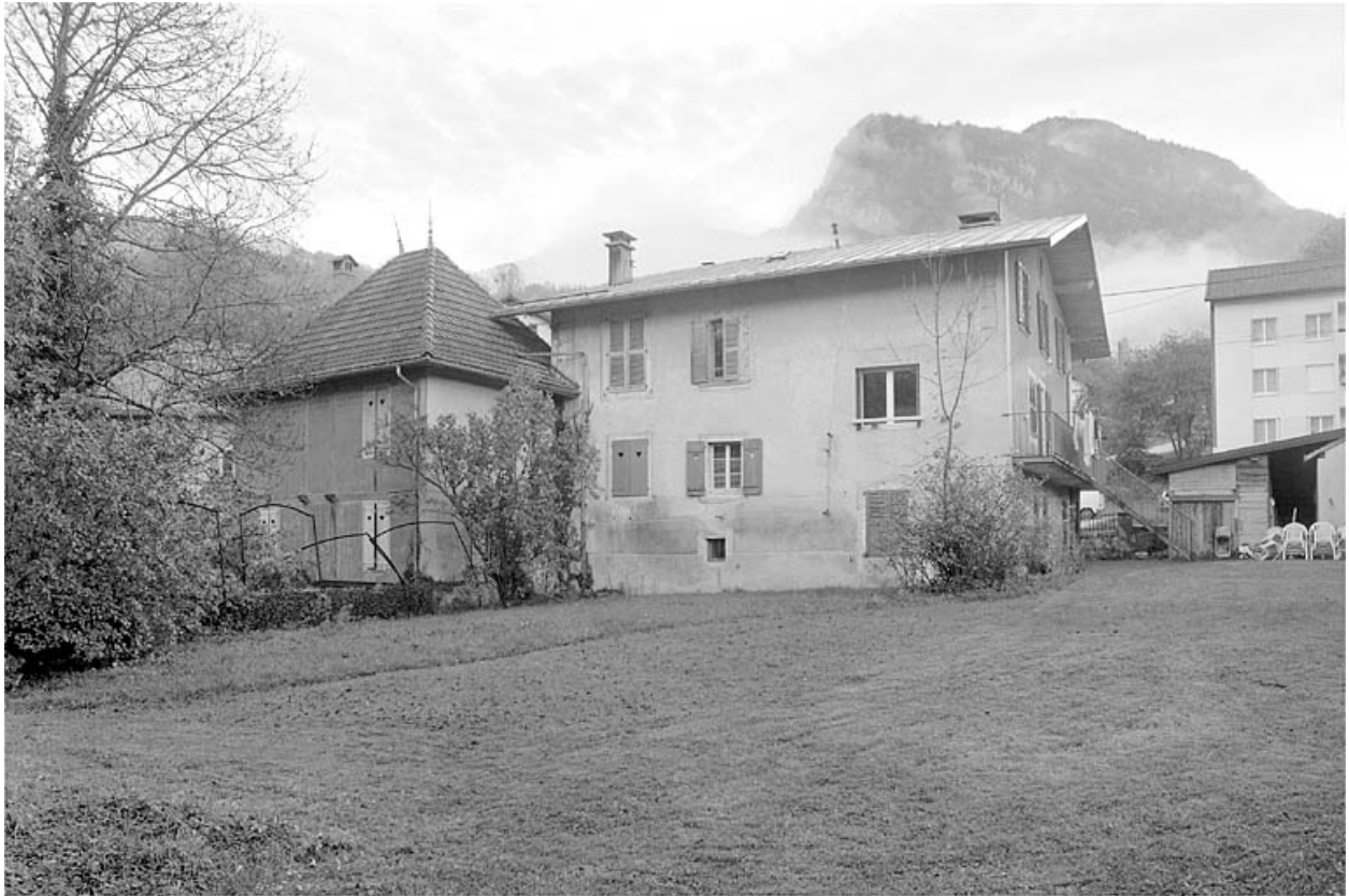
Façade postérieure de l'ensemble.
