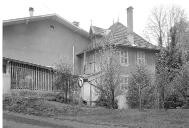
Le second corps de bâtiment. Phot. Jérôme Mongreville IVR43_19963901630X
