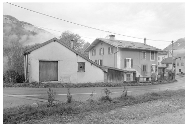
Vue générale du bâtiment et de ses annexes. Phot. Jérôme Mongreville IVR43_19963901629X
