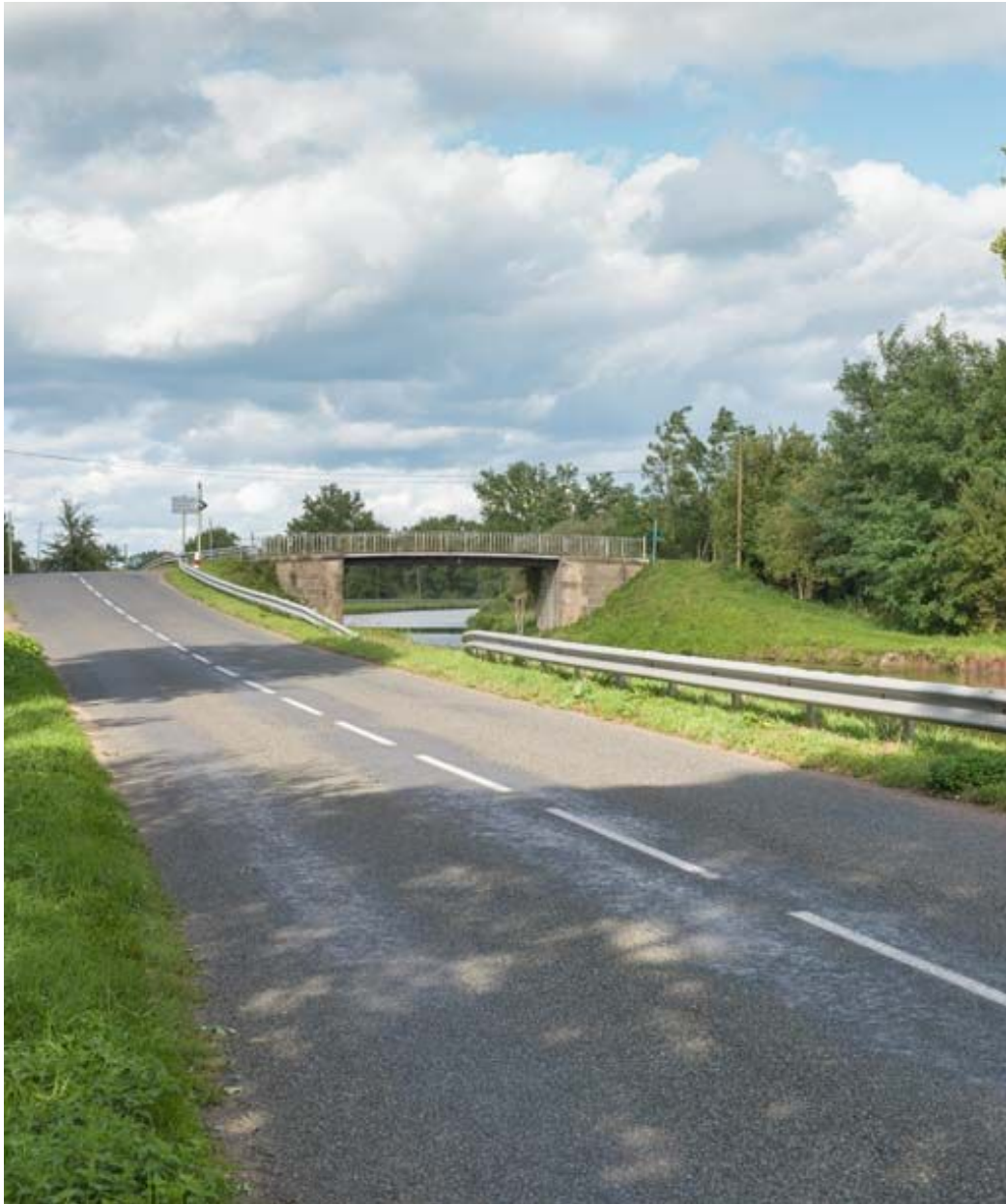
Vue d'ensemble du pont.
