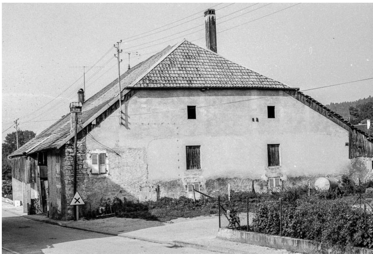
Ferme : façade latérale droite.
