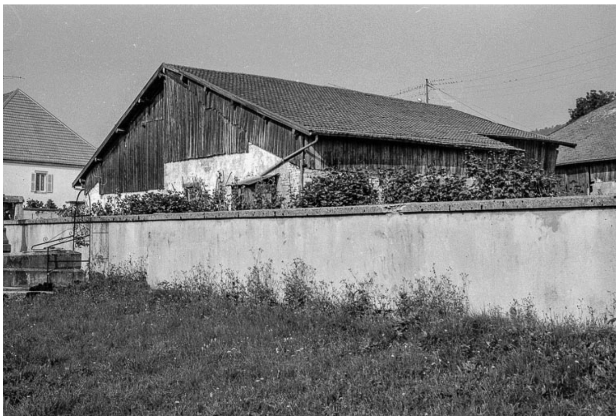
Ferme : façades postérieure et latérale droite.
