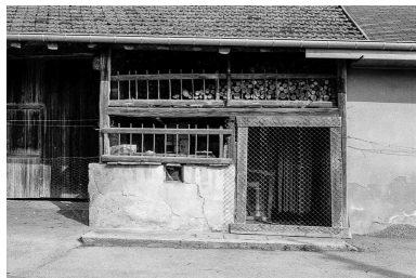
Ferme : détail de la façade antérieure. Phot. Gilbert Poinot IVR43_19752501257Z
