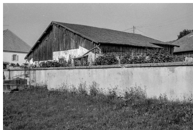
Ferme : façades postérieure et latérale droite. Phot. Gilbert Poinot IVR43_19752501259Z
