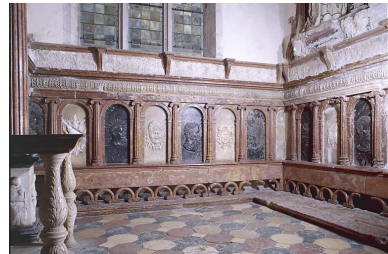
Bas-reliefs n° 4 à 12. Façades sud et ouest de la chapelle. Phot. Yves Sancey IVR43_19977000037XA
