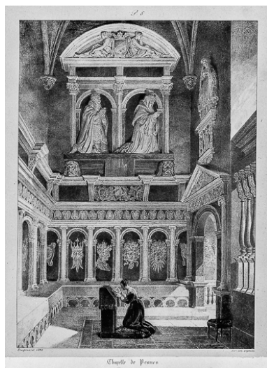
Vue d'ensemble. Phot. Bernard Lardière IVR43_19767000979V
