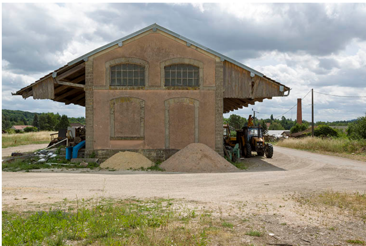
Le hangar de l'ancienne gare.
