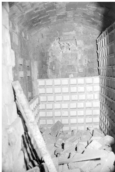
Intérieur du four : le mouflage. Phot. Laurent Poupard IVR43_19883900343Z
