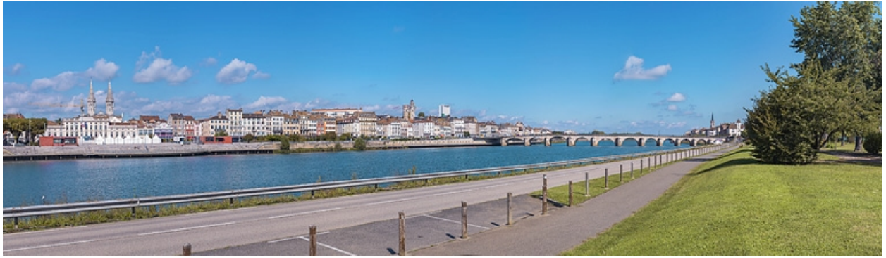
Les quais aval de la ville avec l'aménagement de l'esplanade Lamartine, vus depuis la rive gauche.
