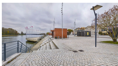
Quai Lamartine avec ses aménagements contemporains. Phot. Thierry Kuntz IVR26_20217100569NUC4A
