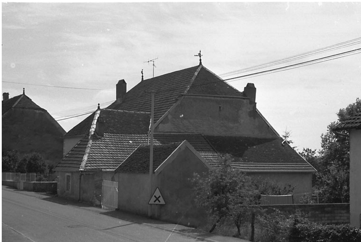
Façade latérale droite.
