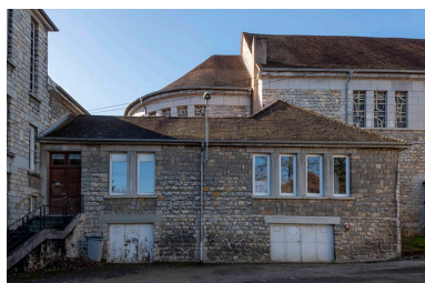
Façade de la sacristie et de la chapelle. En arrière-plan, l'église. Phot. Aline Thomas IVR43_20222500083NUC4A
