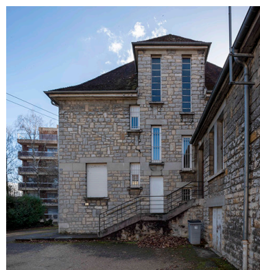
Façade nord du presbytère et bâtiment abritant la chapelle, la sacristie et la chaufferie de l'église. Phot. Aline Thomas IVR43_20222500081NUC4A
