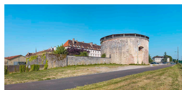
La tour et, à gauche, les restes du mur du bastion détruit. Phot. Thierry Kuntz IVR26_20232100474NUC4A
