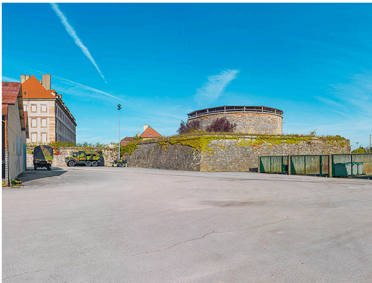
Le bastion depuis l'aire de stationnement du 511 régiment du Train.
