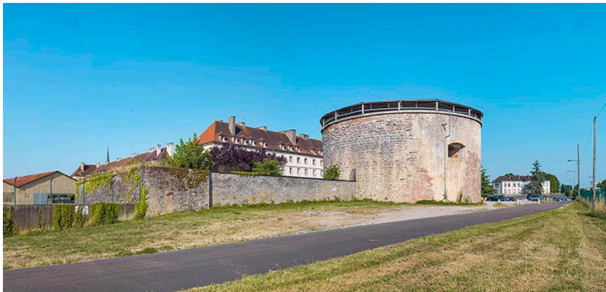
La tour et, à gauche, les restes du mur du bastion détruit.
