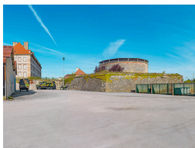
Le bastion depuis l'aire de stationnement du 511 régiment du Train. Phot. Thierry Kuntz IVR26_20232100192NUC4A
