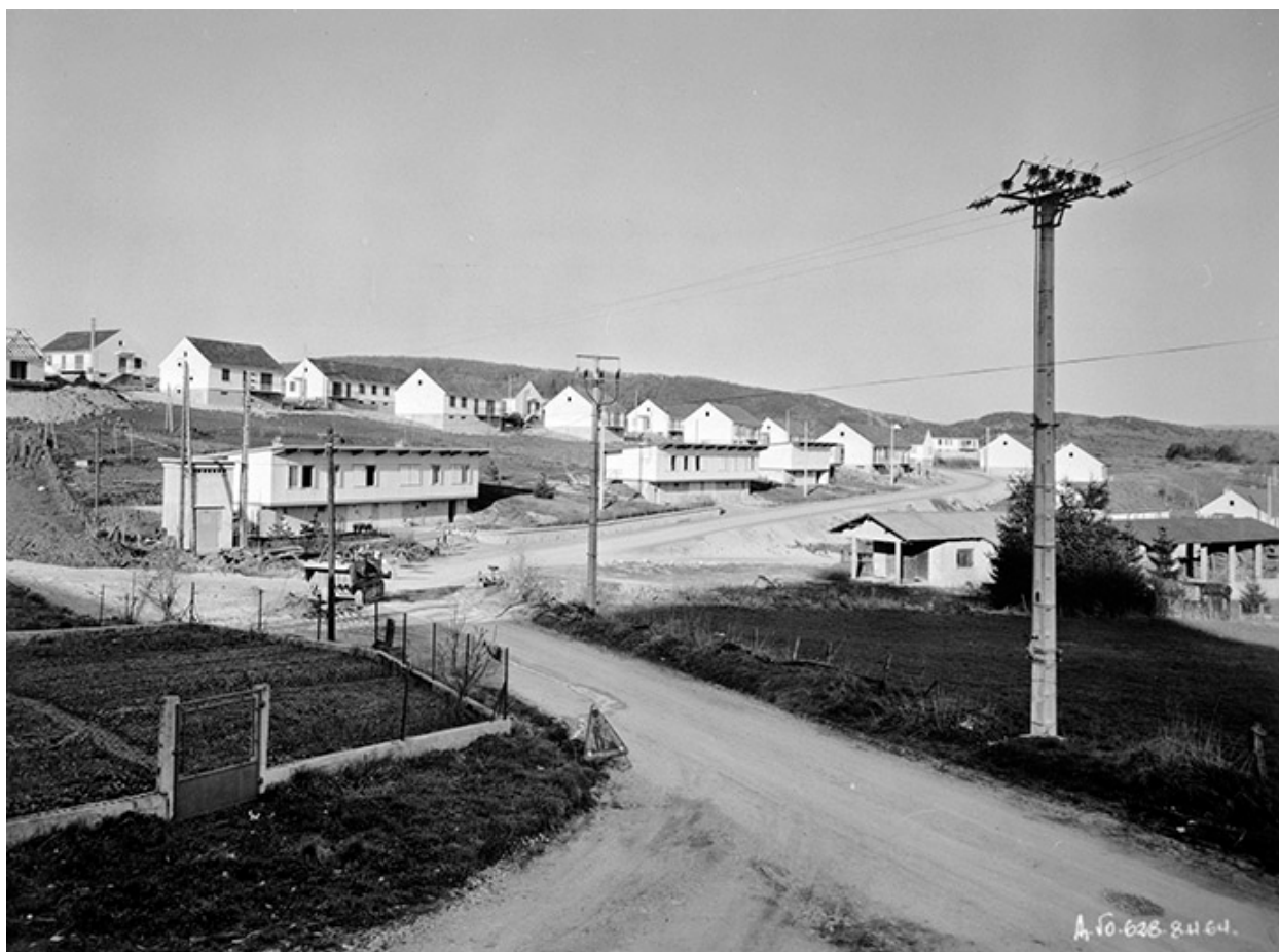
Cité du Closey à Orgelet. Vue générale.
