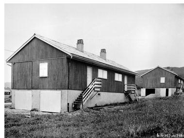
Cité de Vouglans. Logements R.B.M. Phot. Jérôme Mongreville, Autr. Studios Villeurbannais Monchanin et Périchon IVR43_19913900296X
