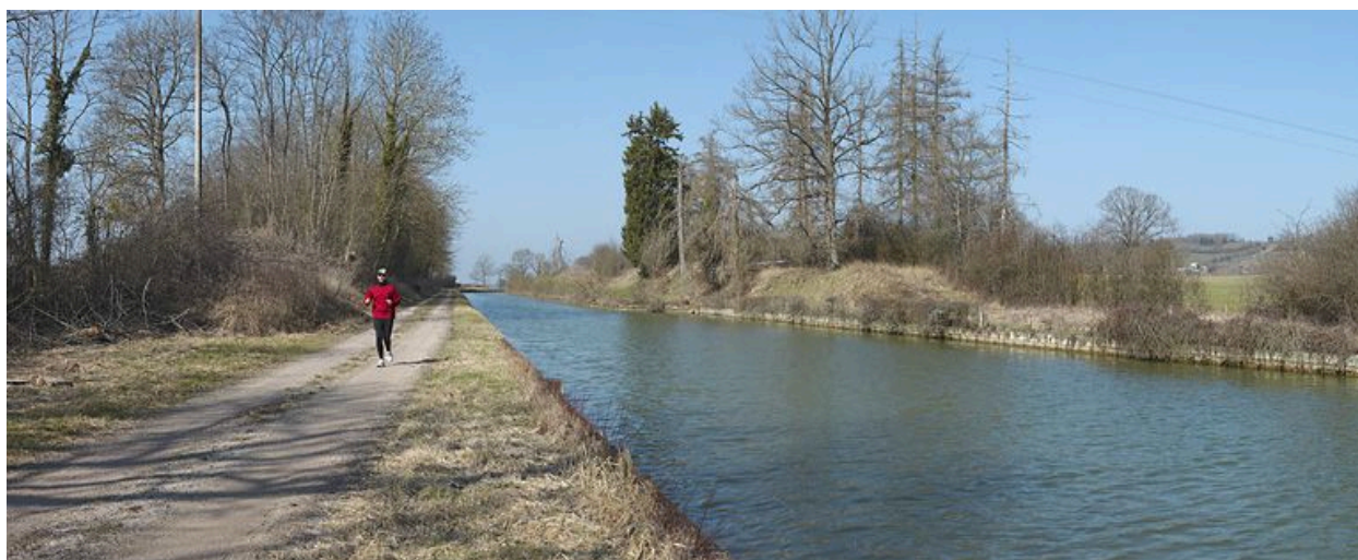
Entrée de la tranchée.
