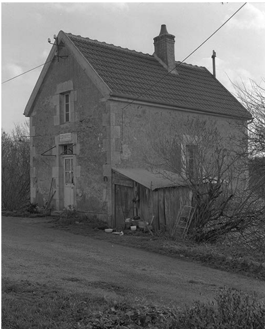
La maison d'éclusier.
