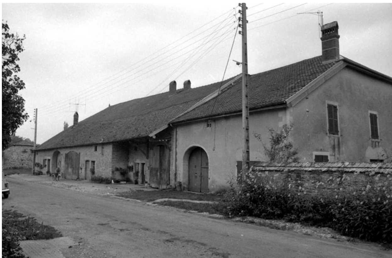
Façades antérieure et latérale droite.
