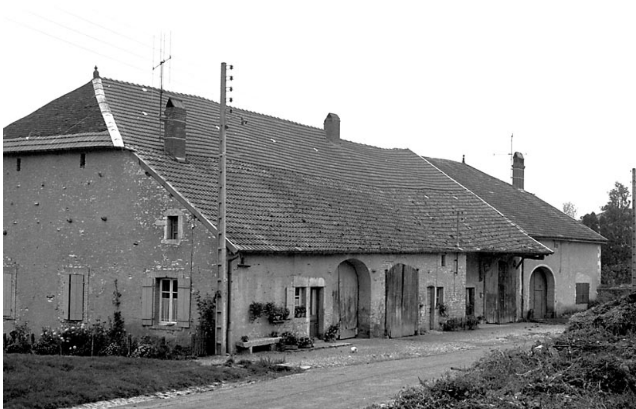
Façades antérieure et latérale gauche.
