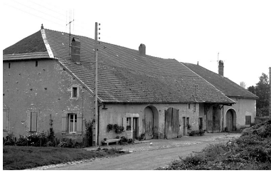
Façades antérieure et latérale gauche.
