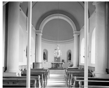
Intérieur : nef et chœur. Phot. Yves Sancey IVR43_19792500510V
