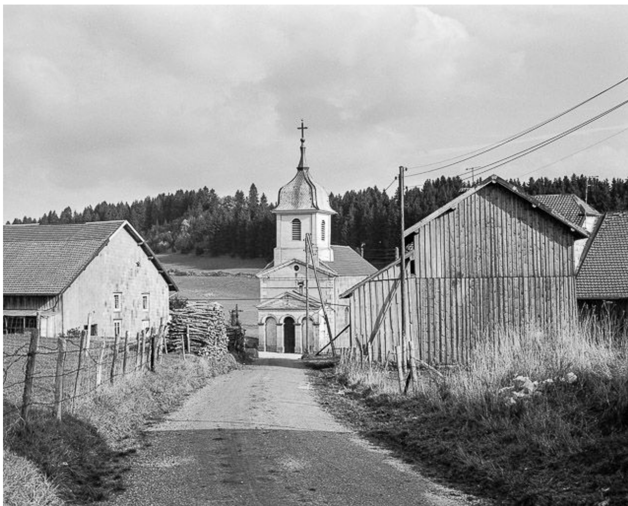
Façades antérieure et latérale droite.
