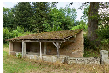
Lavoir, rue des Forges. Phot. Sonia Dourlot IVR43_20157000564NUC2A
