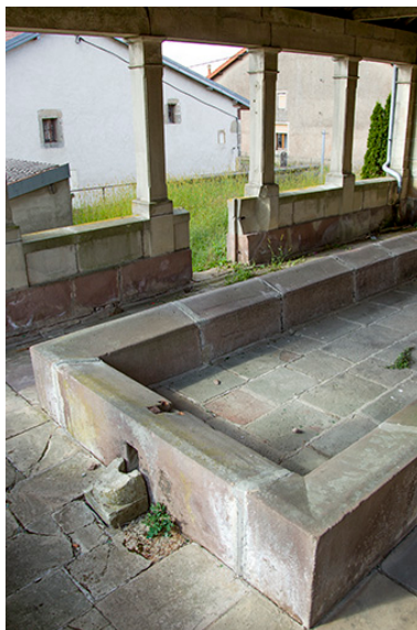
Bassin du lavoir rue Saint-Antoine. Phot. Sonia Dourlot IVR43_20157000569NUC2A
