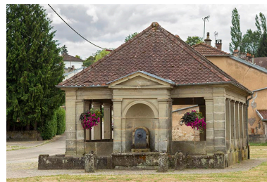
Fontaine-lavoir, rue Traversière. Phot. Sonia Dourlot IVR43_20157000570NUC2A
