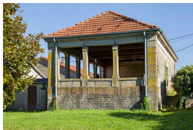
Façade sud de la fontaine-lavoir rue Saint-Antoine. Phot. Sonia Dourlot IVR43_20157000568NUC2A
