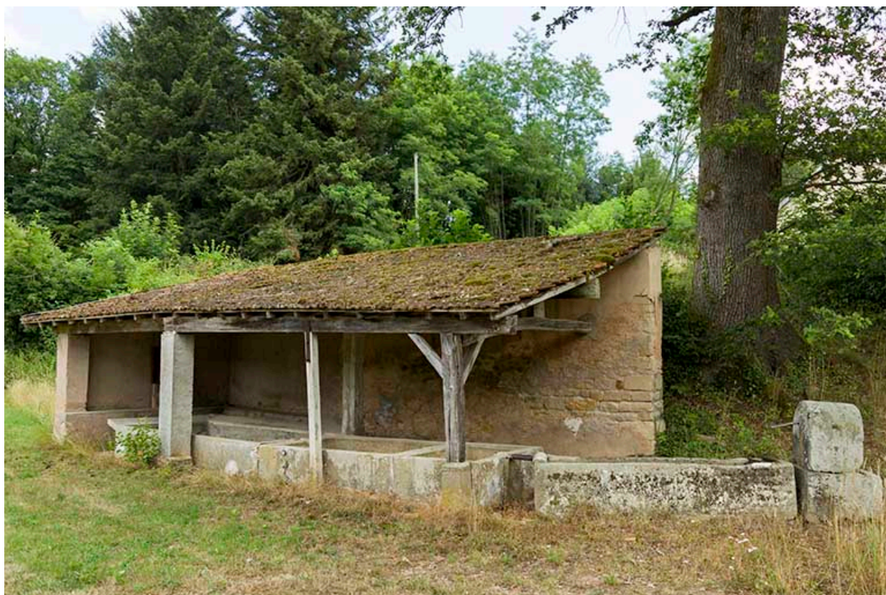
Lavoir, rue des Forges.
