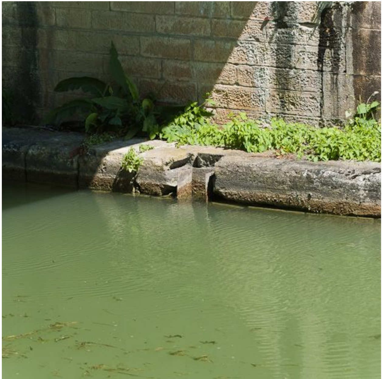
Détail d'une encoche à batardeau sous le pont.
