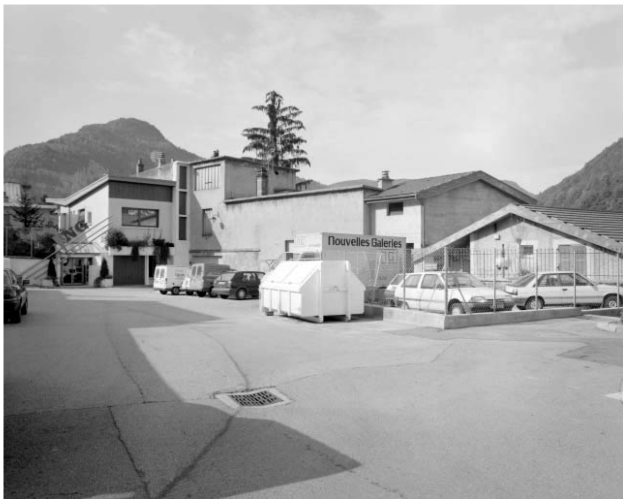
Façade orientale des bâtiments.
