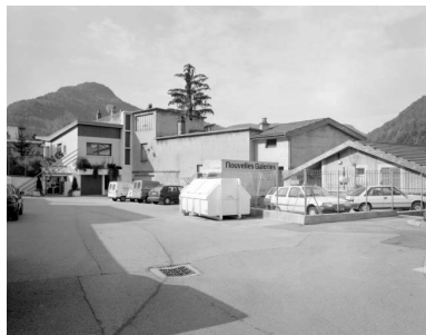
Façade orientale des bâtiments. Phot. Jérôme Mongreville IVR43_19923900623X
