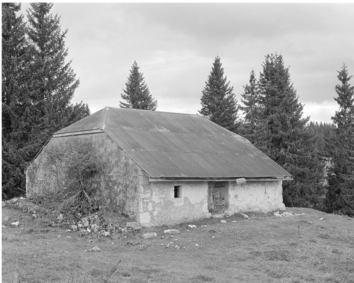
Façade antérieure et face sud-ouest.
