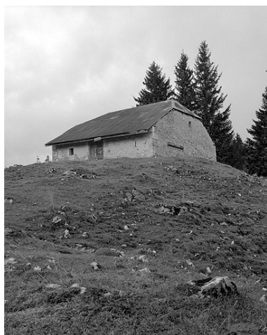
Façade antérieure et face nord-est. Phot. Jérôme Mongreville IVR43_19963901374X
