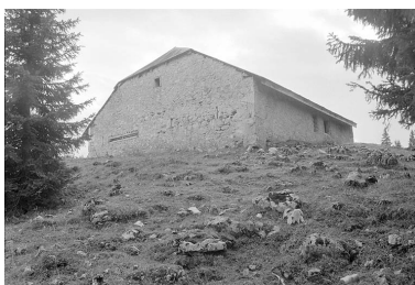
Face nord-est et façade postérieure. Phot. Jérôme Mongreville IVR43_19963901375X
