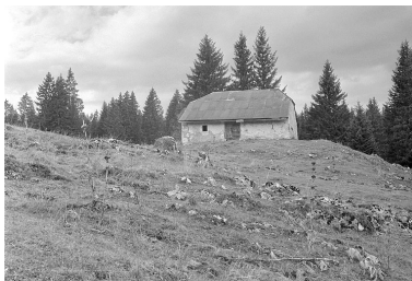
Façade antérieure. Phot. Jérôme Mongreville IVR43_19963901366X
