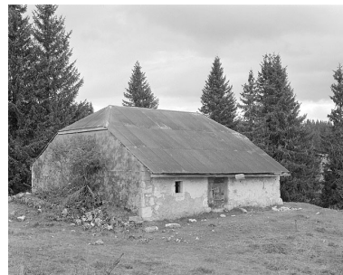
Façade antérieure et face sud-ouest. Phot. Jérôme Mongreville IVR43_19963901367X
