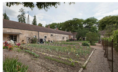
Vue de la cour intérieure. Phot. Pierre-Marie Barbe-Richaud IVR26_20112103669NUC4AQ
