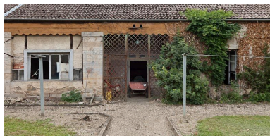
Vue d'un garage dans la cour intérieure. Phot. Pierre-Marie Barbe-Richaud IVR26_20112103672NUC4AQ
