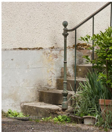
Détail d'un départ de rampe. Phot. Pierre-Marie Barbe-Richaud IVR26_20112103661NUC2AQ
