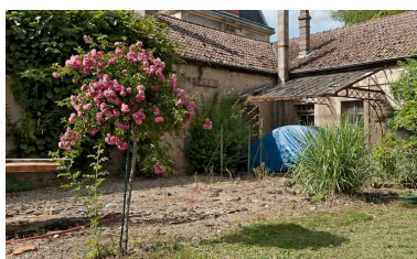
Détail d'une partie de la cour intérieure. Phot. Pierre-Marie Barbe-Richaud IVR26_20112103670NUC4AQ
