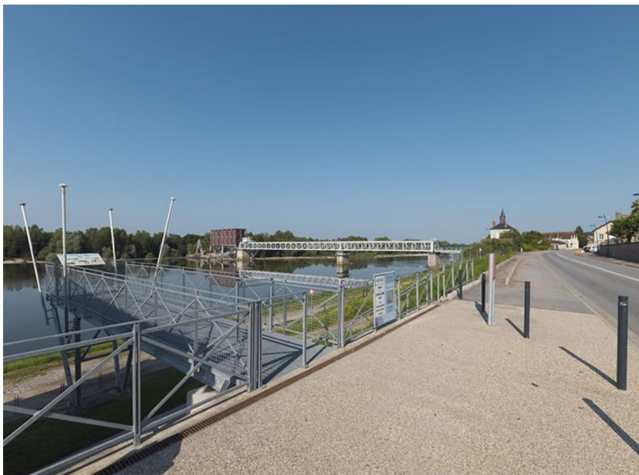
Vue d'ensemble du barrage.
