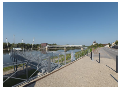
Vue d'ensemble du barrage. Phot. Thierry Kuntz IVR26_20135800363NUC4A
