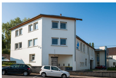
Pignon est du bâtiment d'administration et d'externat. Phot. Jérôme Mongreville IVR43_20132501582NUC4A
