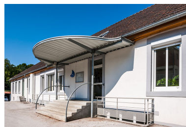
Détail de l'entrée postérieure du bâtiment d'externat. Phot. Jérôme Mongreville IVR43_20132501610NUC4A
