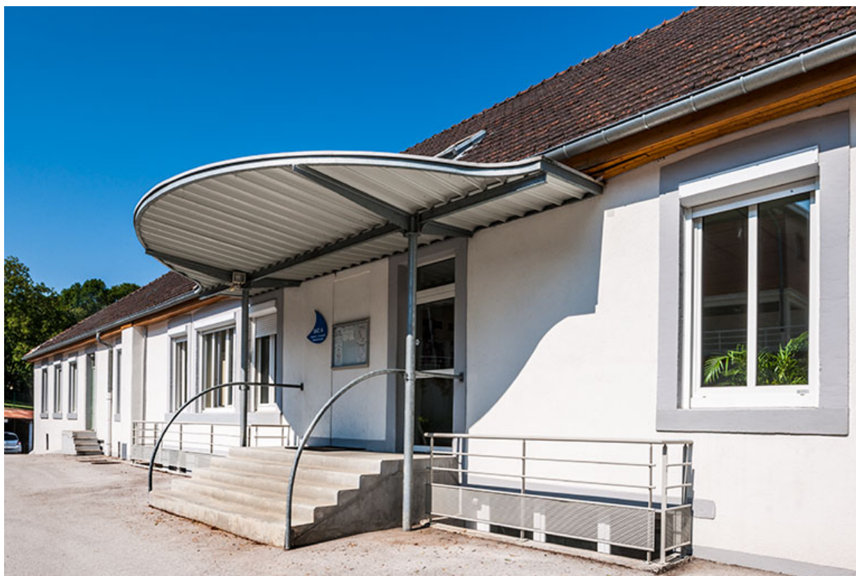
Détail de l'entrée postérieure du bâtiment d'externat.
