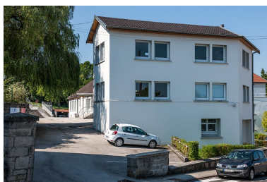
Pignon est du bâtiment d'administration et d'externat. Phot. Jérôme Mongreville IVR43_20132501611NUC4A
