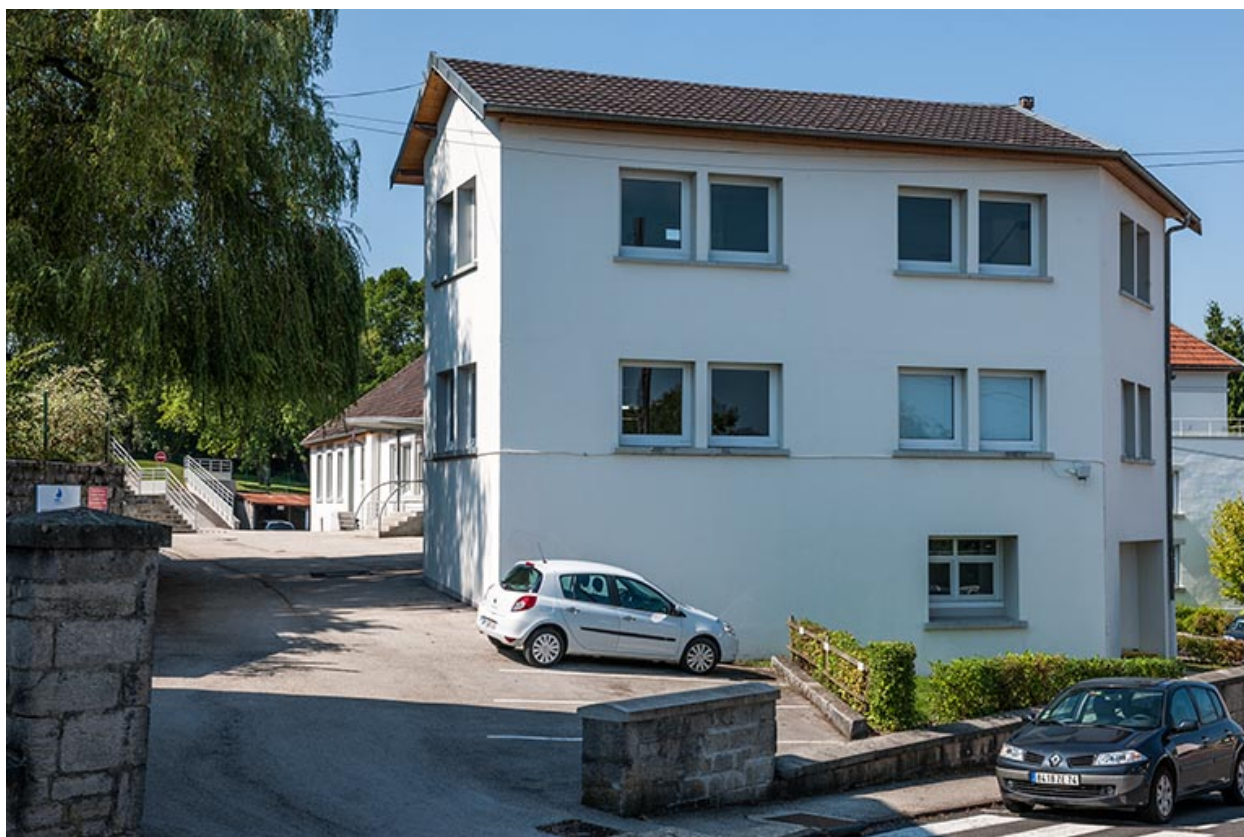
Pignon est du bâtiment d'administration et d'externat.
