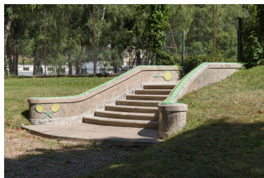
Escalier conduisant aux courts de tennis, vue de trois-quarts. Phot. Pierre-Marie Barbe-Richaud IVR26_20195800386NUC4A
