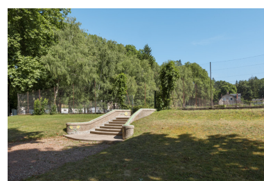
Vue des courts de tennis depuis le club-house. Phot. Pierre-Marie Barbe-Richaud IVR26_20195800385NUC4A
