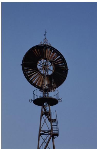
Vue prise du sud-est. Phot. Jean-Luc Duthu IVR26_19925800294ZA
