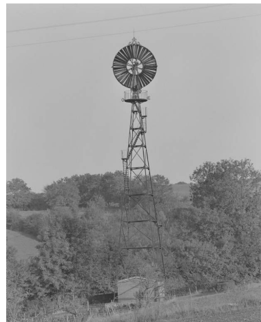
Vue d'ensemble prise du sud-est. Phot. Jean-Luc Duthu IVR26_19925800026X
