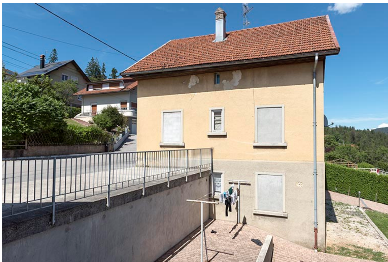
Façade latérale droite.
