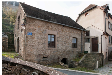
Vue générale. Phot. Jérôme Mongreville IVR43_20102500401NUC4A
