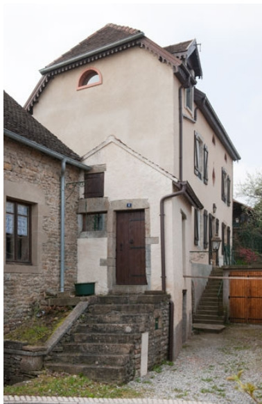
Habitation : façade latérale gauche et façade antérieure. Phot. Jérôme Mongreville IVR43_20102500400NUC4A
