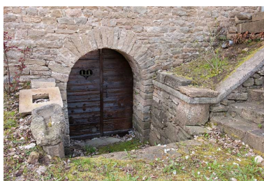
Grange : porte de cave sur la façade antérieure. Phot. Jérôme Mongreville IVR43_20102500403NUC4A
