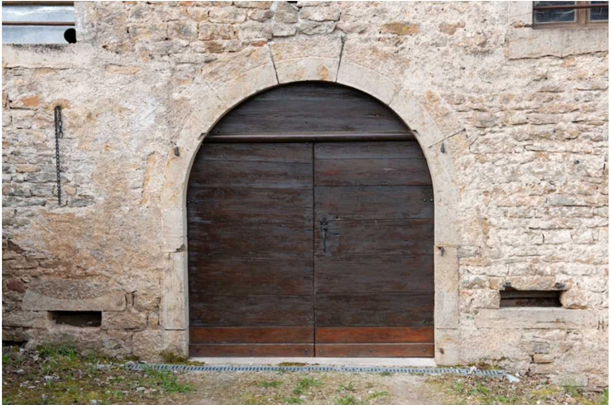
Grange : porte sur la façade latérale gauche.
