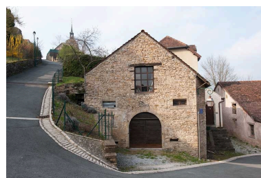
Grange : façade latérale gauche. Phot. Jérôme Mongreville IVR43_20102500399NUC4A
