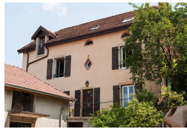
Façade antérieure. Phot. Jérôme Mongreville IVR43_20102501051NUC4A
