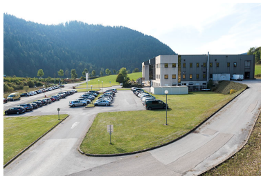
Façade latérale droite et stationnement. Phot. Sonia Dourlot IVR43_20162501265NUC4A
