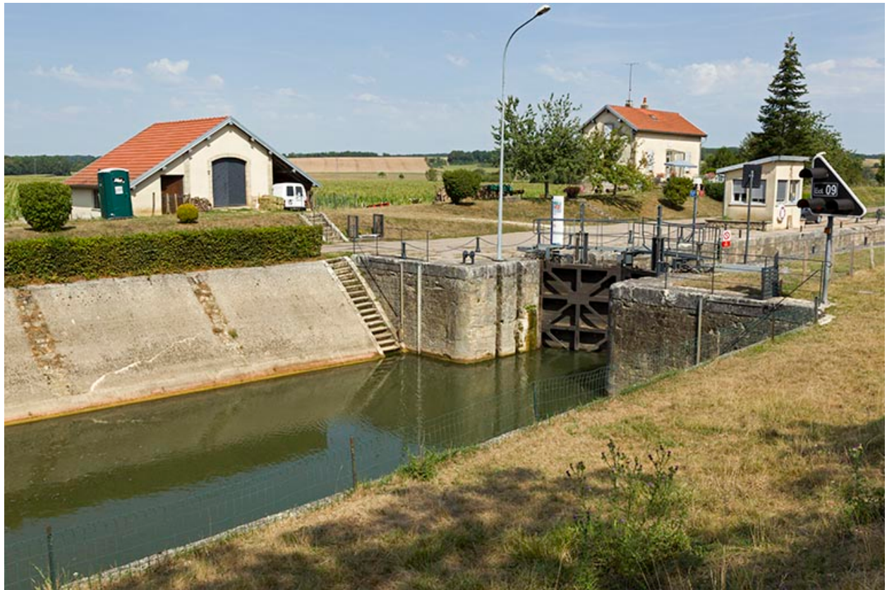
Entrée de l'écluse à sas.
