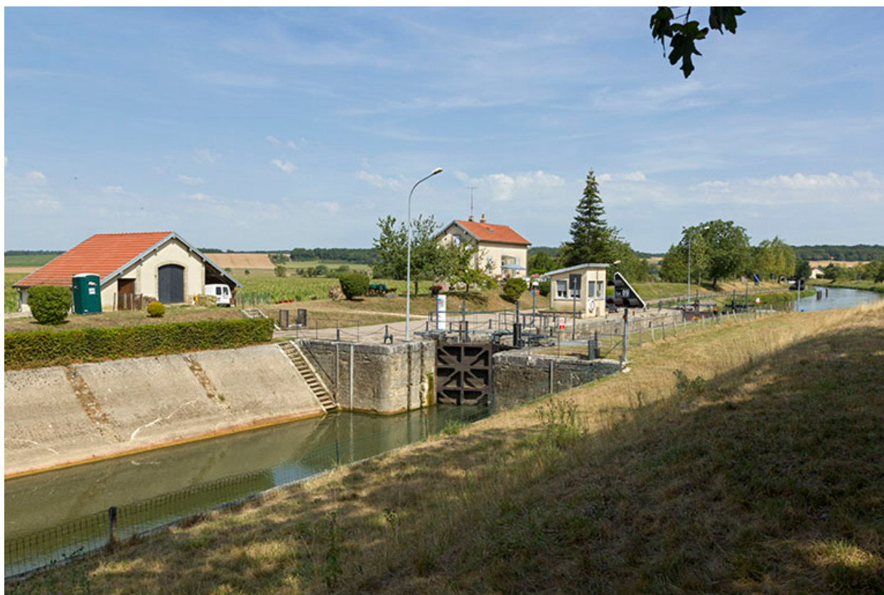
Vue générale du site d'écluse.
