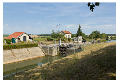
Vue générale du site d'écluse. Phot. Sonia Dourlot IVR43_20157000792NUC2A
