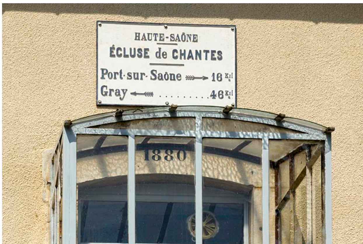
Plaque signalétique de l'écluse.
