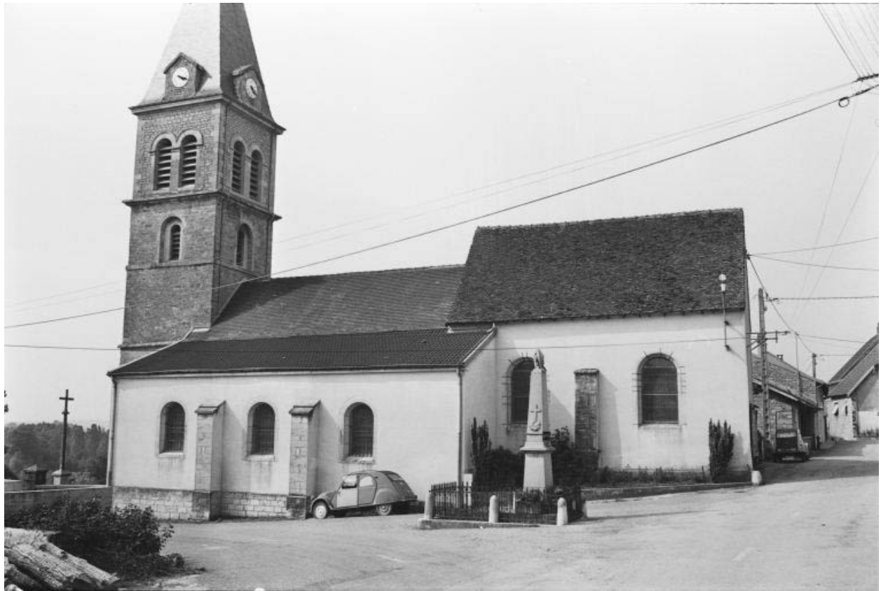
Façade latérale droite.
