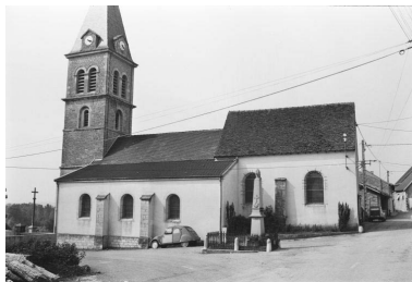
Façade latérale droite. Phot. Guy Forestier IVR43_19743901021Z
