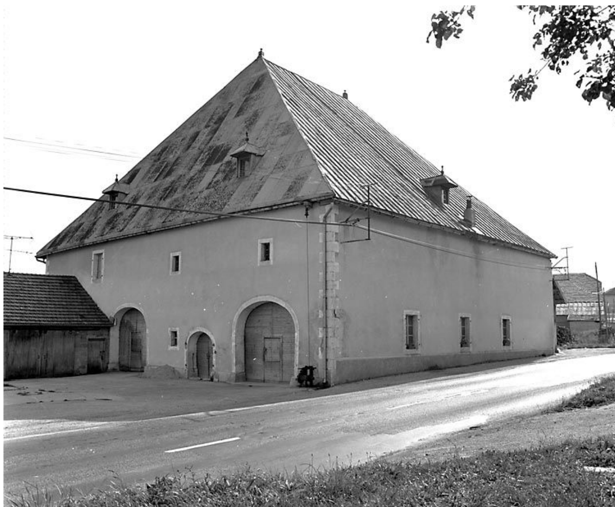
Ferme située 35 rue Principale.
