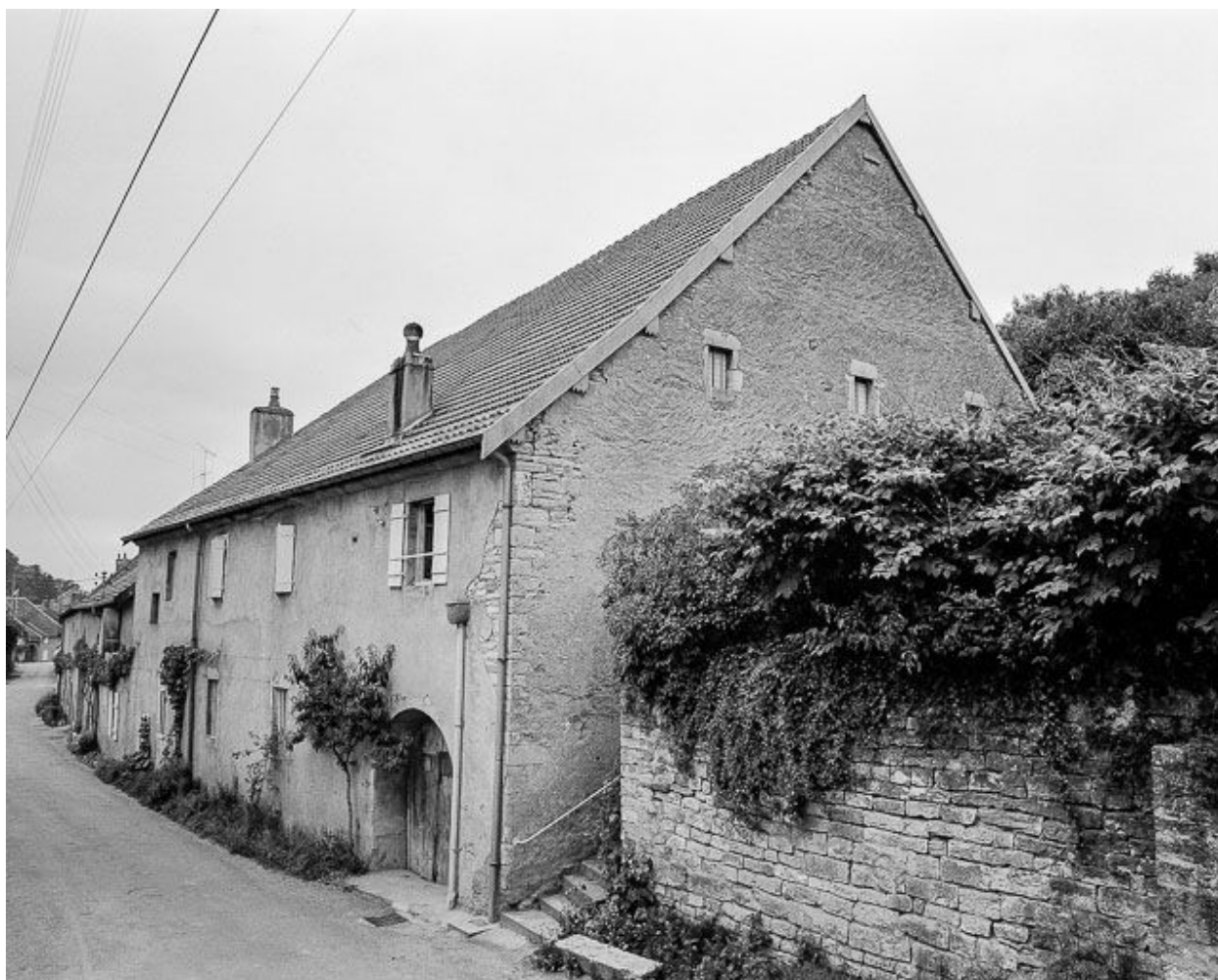
Maison située 7 chemin des Ecoliers.
