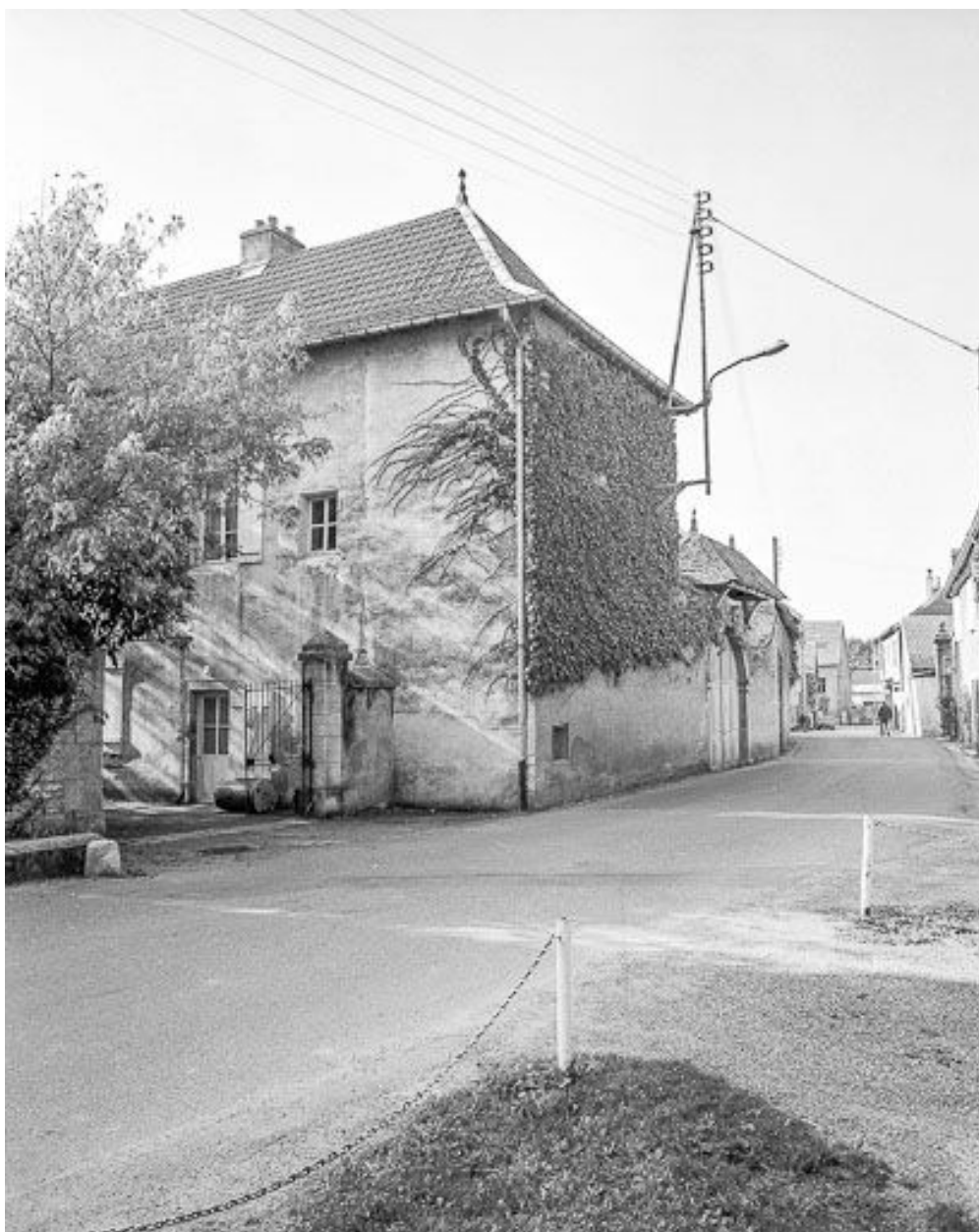
Ferme située rue du Canal.
