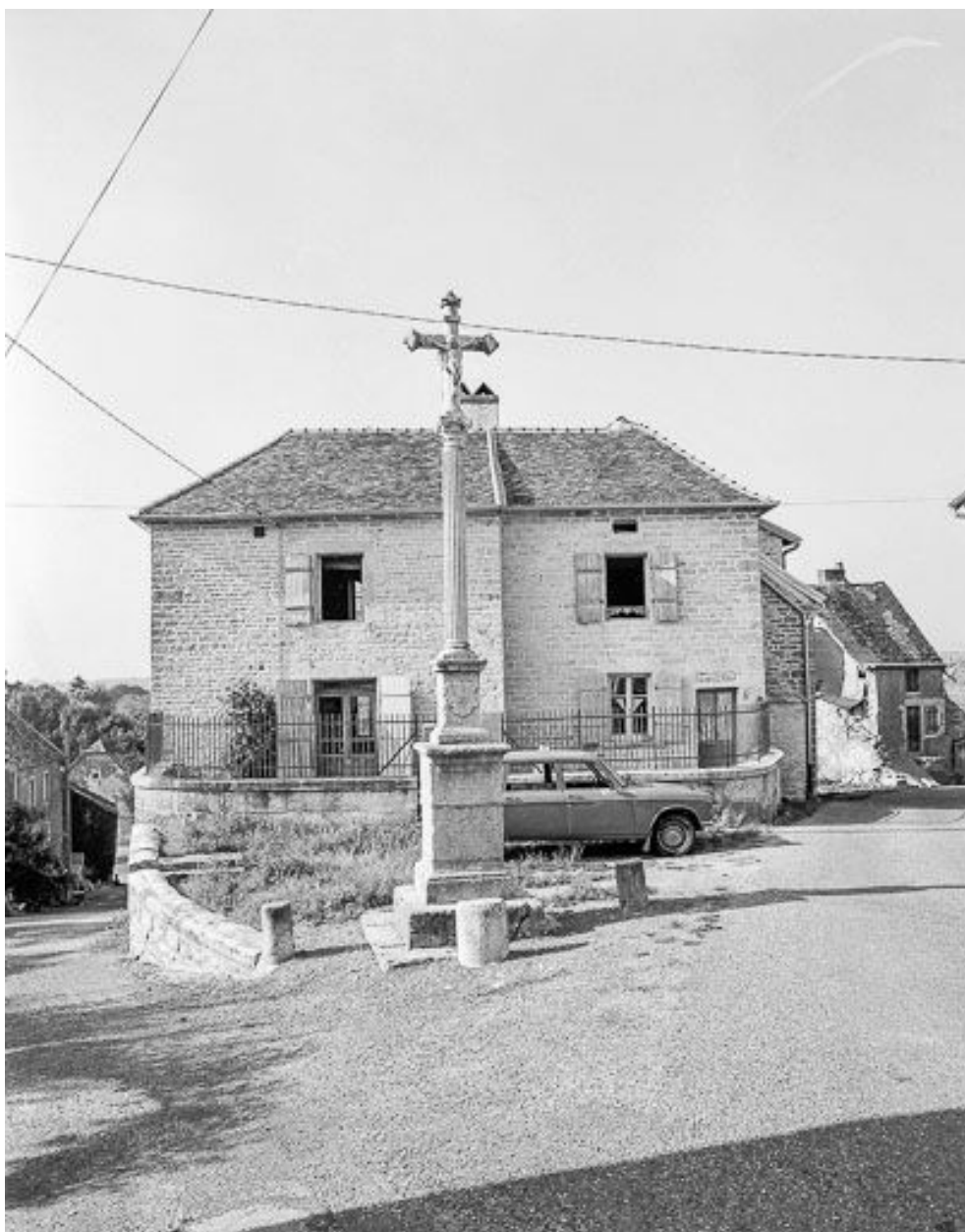
Maison située 1 rue du Mont.
