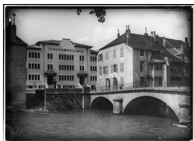
Vue de situation [1re moitié 20e siècle]. Autr. Jules Manias IVR43_20062500960PY
