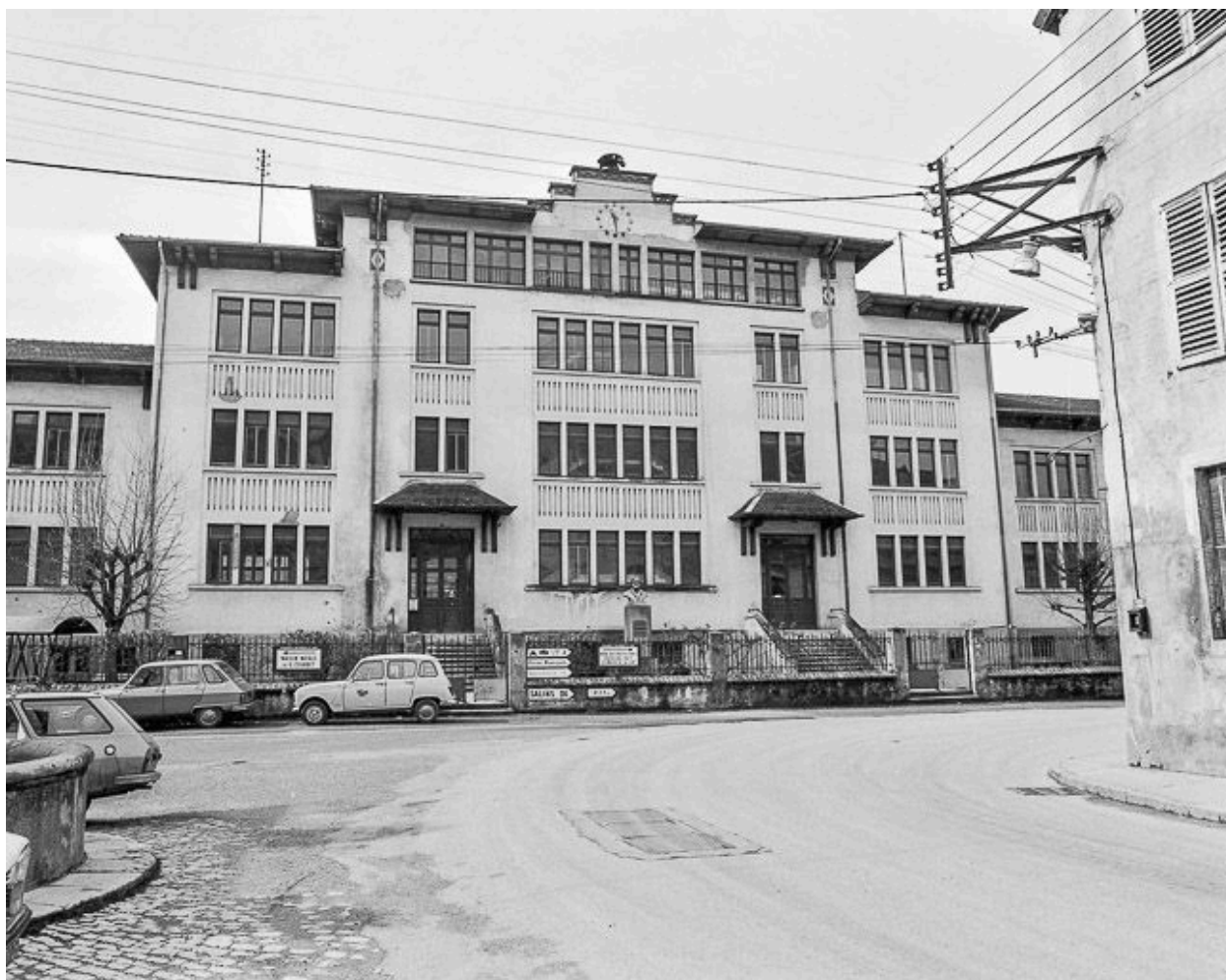
Vue d'ensemble (bâtiment détruit).
