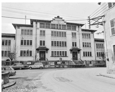
Vue d'ensemble (bâtiment détruit). Phot. Yves Sancey IVR43_19772500071X
