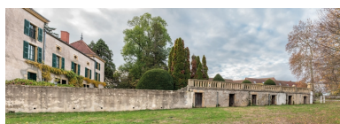
Vue du château, du mur de soutènement de la cour et des chenils Phot. Pierre-Marie Barbe-Richaud IVR26_20187100783NUC4AQ
