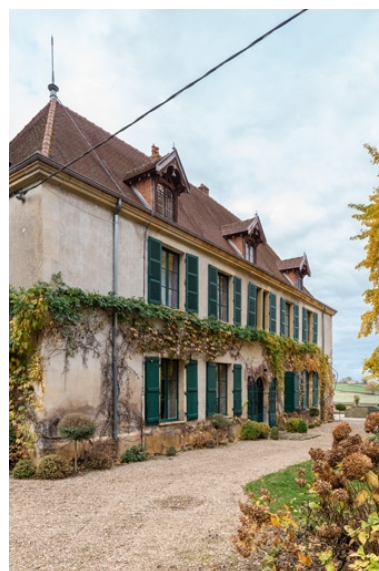
Façade postérieure du château Phot. Pierre-Marie Barbe-Richaud IVR26_20187100779NUC4A
