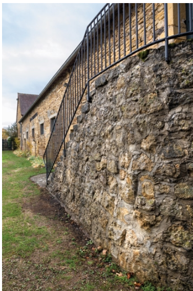
Vue de la grange et de l'escalier, à l'extrémité nord du bâtiment, dont la maçonnerie présente des fossiles Phot. Pierre-Marie Barbe-Richaud IVR26_20187100792NUC4A
