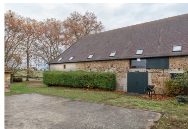
Façade antérieure de la grange Phot. Pierre-Marie Barbe-Richaud IVR26_20187100788NUC4A
