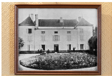
Vue de la façade antérieure du château au début du XXe siècle Phot. Pierre-Marie Barbe-Richaud IVR26_20187100802NUC4A
