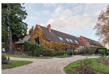
Vue des dépendances dont le bâtiment abritant l'ancien fournil au premier plan Phot. Pierre-Marie Barbe-Richaud IVR26_20187100784NUC4A
