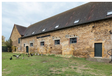
Façade antérieure de la grange, modifiée au XXe siècle Phot. Pierre-Marie Barbe-Richaud IVR26_20187100790NUC4A
