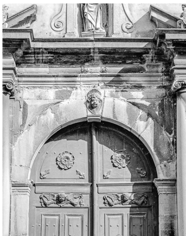
Portail de la façade antérieure : : partie supérieure. Phot. Yves Sancey IVR43_19833900013X
