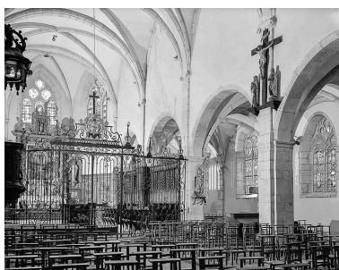
Intérieur : élévation droite vue depuis la nef . Phot. Yves Sancey IVR43_19763900035V
