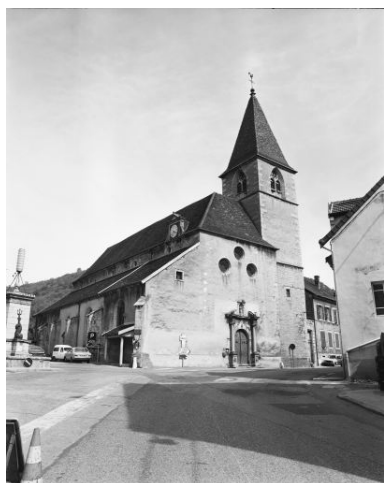
Vue d'ensemble de trois quarts gauche. Phot. Yves Sancey IVR43_19813900002X
