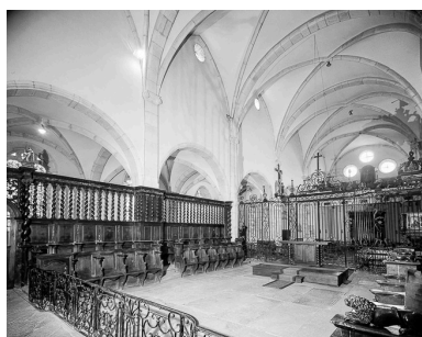
Intérieur : nef et avant-choeur, élévation droite vue depuis le choeur . Phot. Yves Sancey IVR43_19763900040V
