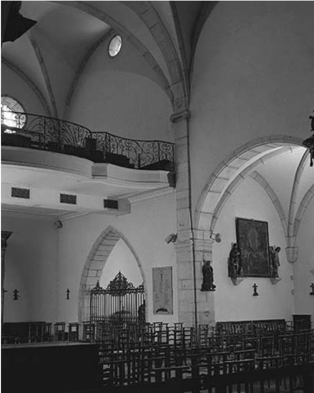
Intérieur : élévation gauche de la première travée de la nef .
