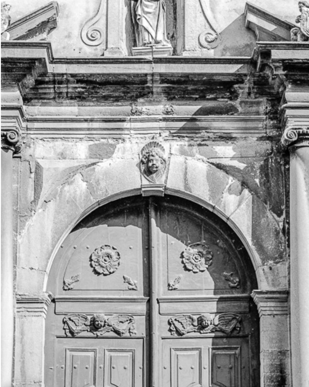
Portail de la façade antérieure : : partie supérieure.
