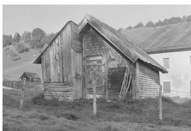
Le grenier fort. Phot. Jérôme Mongreville IVR43_19963901572X
