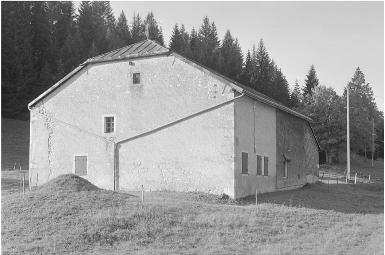
Face nord-est de la ferme et citerne.
