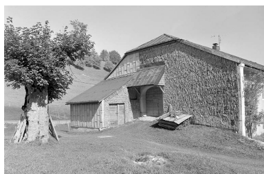
Face sud-ouest. Phot. Jérôme Mongreville IVR43_19963901570X
