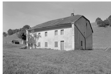
Façade antérieure. Phot. Jérôme Mongreville IVR43_19963901574X
