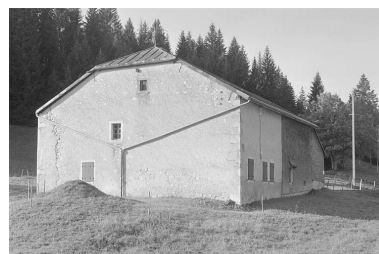
Face nord-est de la ferme et citerne. Phot. Jérôme Mongreville IVR43_19963901571X
