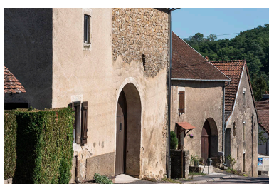
Alignement de fermes. Phot. Jérôme Mongreville IVR43_20177001234NUC4A
