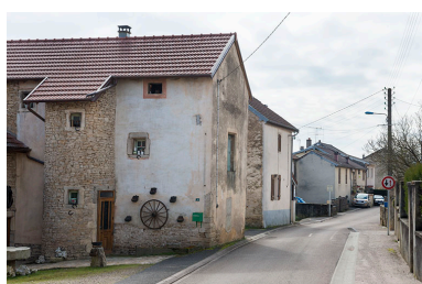
Ferme en équerre dotée d'une tour. Phot. Jérôme Mongreville IVR43_20187000096NUC4A
