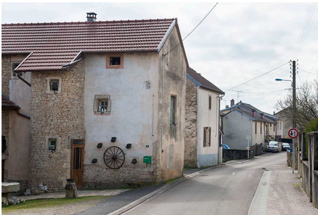
Ferme en équerre dotée d'une tour.
