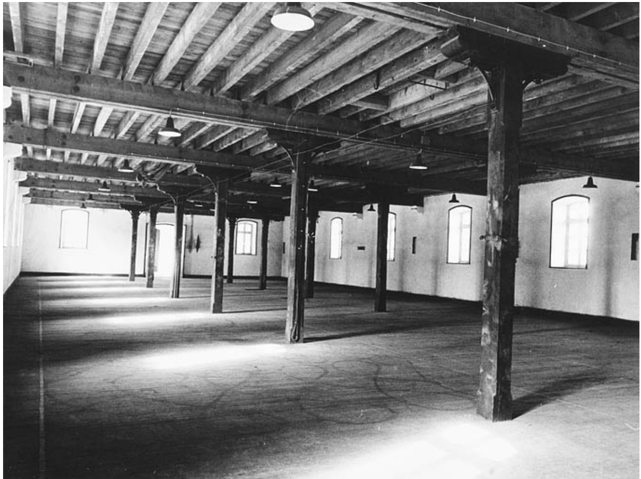
Etage du bâtiment B ou C.
