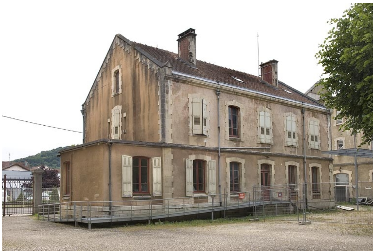
Façade postérieure du bâtiment des bureaux.
