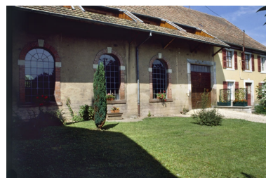
Façade de l'atelier mécanique.
