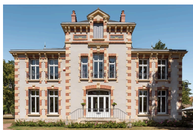
Vue de face, depuis l'avenue. Phot. Pierre-Marie Barbe-Richaud IVR26_20205800441NUC4A
