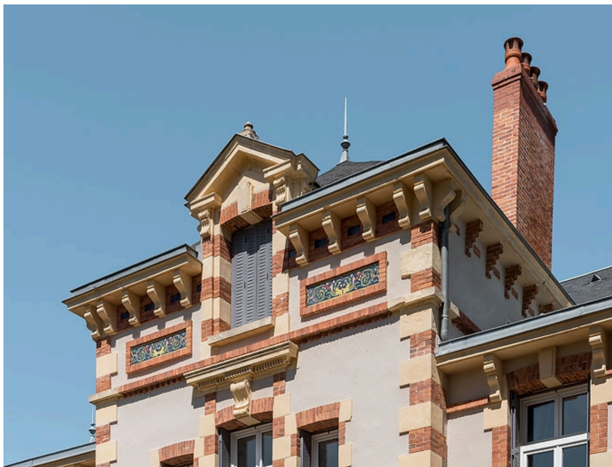
Avant-corps central de la façade principale, détail.
