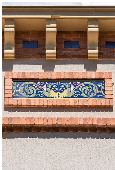
Avant-corps central de la façade principale, détail.
