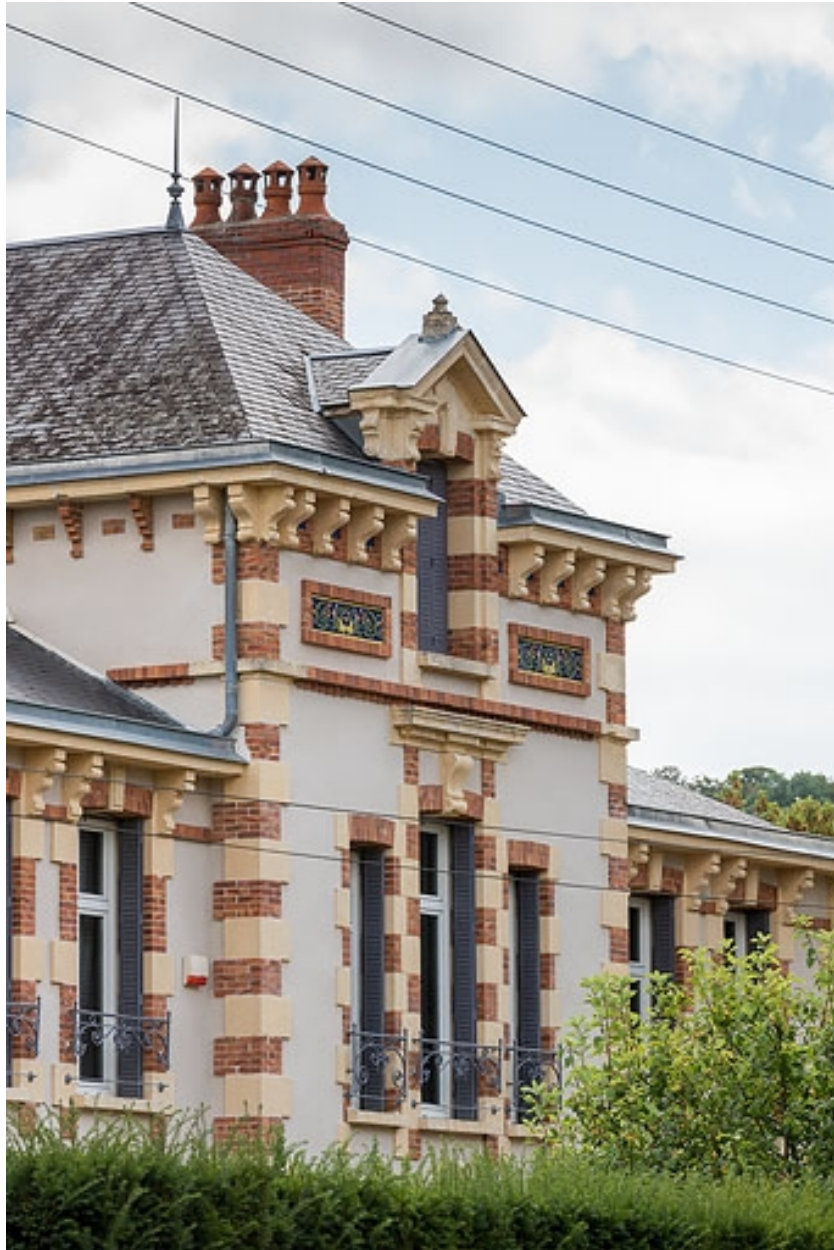
Avant-corps central de la façade principale, détail.
