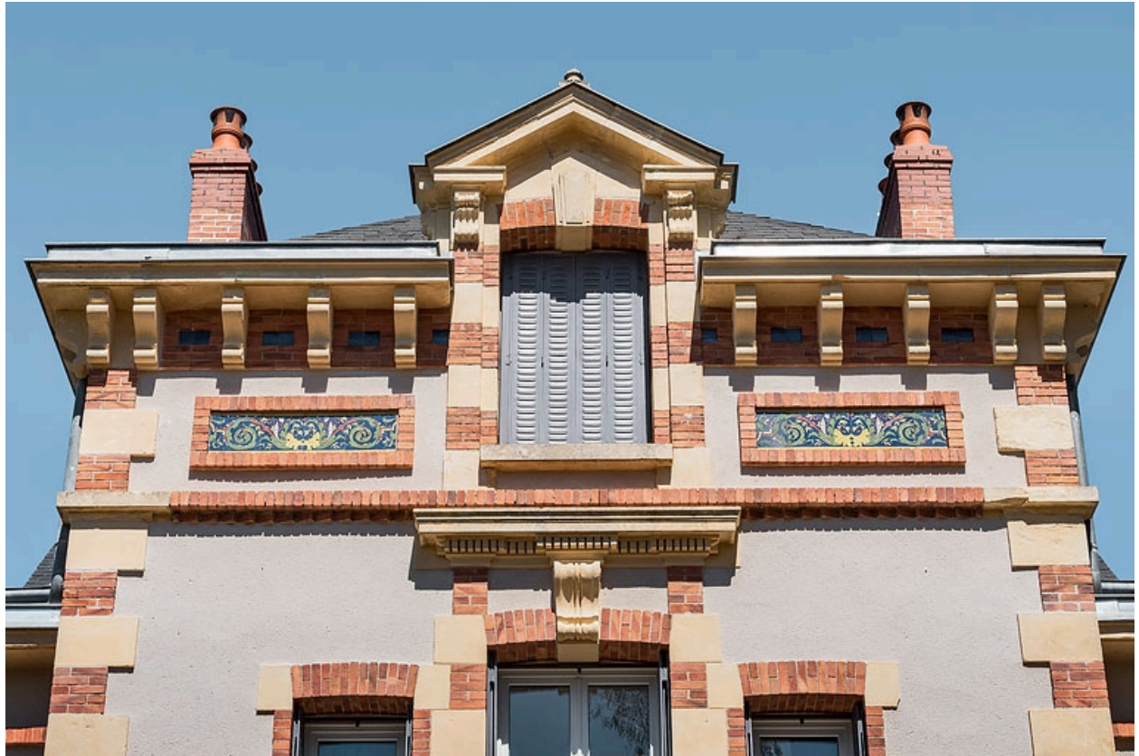
Avant-corps central de la façade principale, détail.
