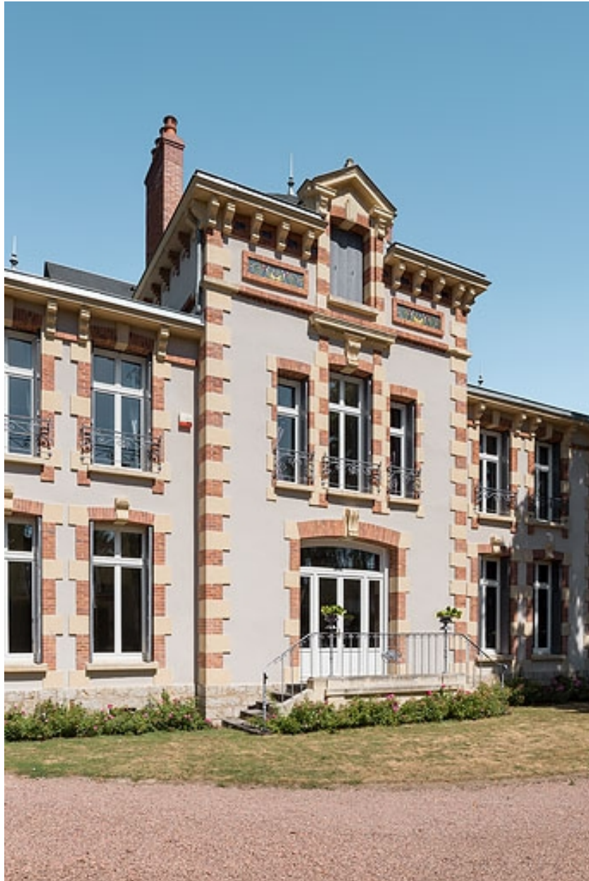
Avant-corps central de la façade principale.
