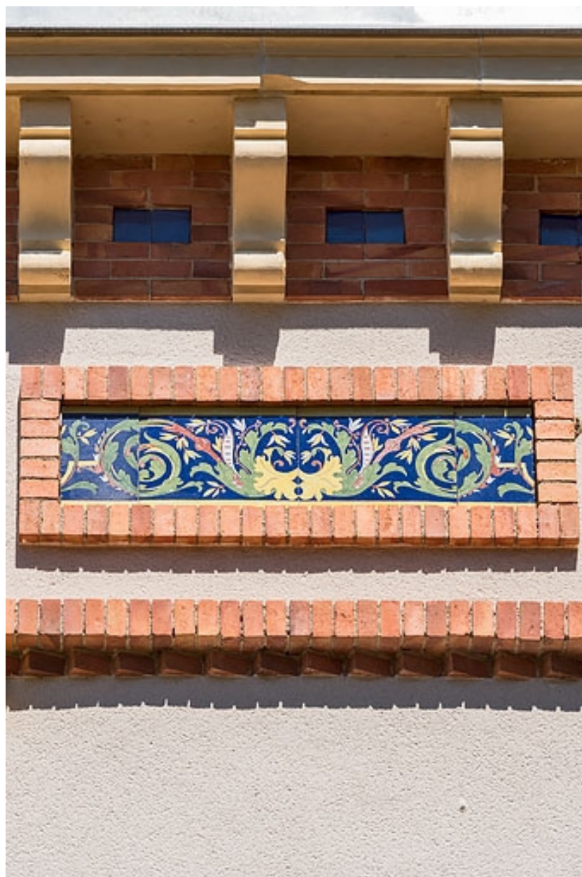
Avant-corps central de la façade principale, détail.
