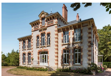
Vue de trois-quarts, depuis l'avenue. Phot. Pierre-Marie Barbe-Richaud IVR26_20205800442NUC4A
