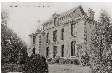
Façade nord-est. Phot. auteur inconnu IVR26_20195800740NUC4A
