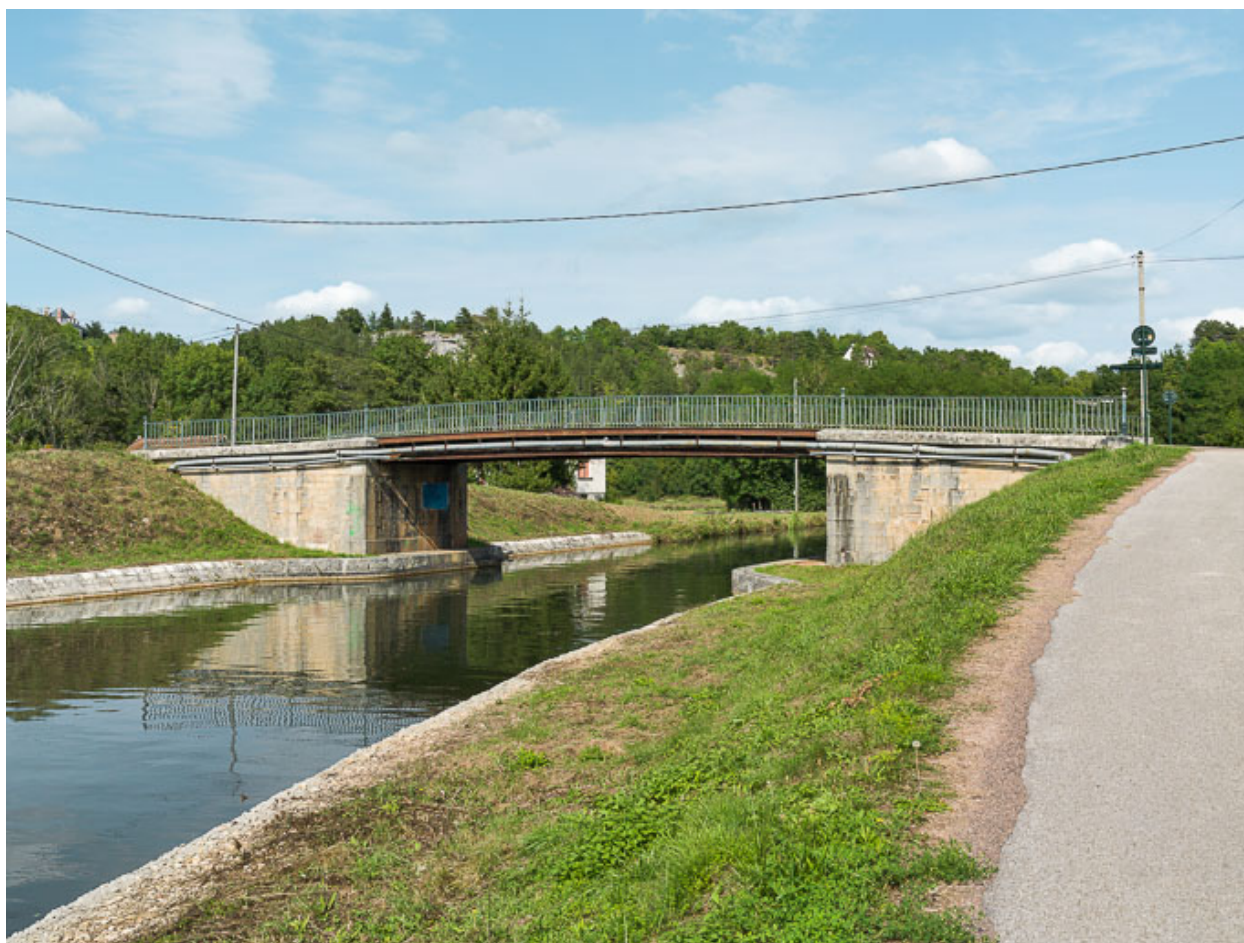
Vue d'ensemble du pont.
