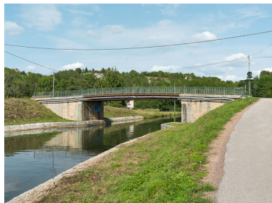
Vue d'ensemble du pont.
