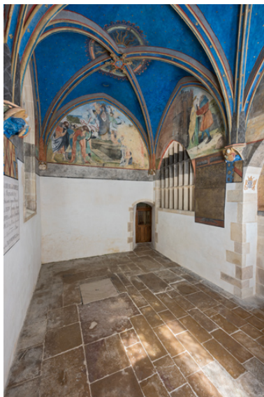
Chapelle de Lugny (vue intérieure en direction du nord-ouest). Phot. Pierre-Marie Barbe-Richaud IVR26_20237100158NUC4A
