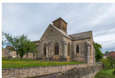
Flanc sud, avec la chapelle de Lugny et le chœur (vue depuis le sud). Phot. Pierre-Marie Barbe-Richaud IVR26_20247100005NUC4A
