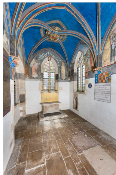
Chapelle de Lugny (vue intérieure en direction du sud-est). IVR26_20237100162NUC4A
