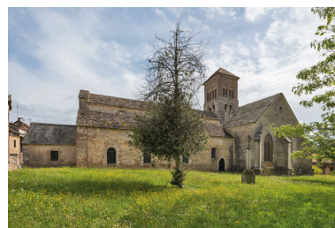
Flanc sud, avec la nef (vue depuis le sud-ouest). Phot. Pierre-Marie Barbe-Richaud IVR26_20247100009NUC4A
