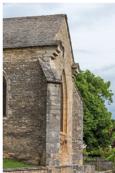
Chevet (vue depuis le sud). Phot. Pierre-Marie Barbe-Richaud IVR26_20247100006NUC4A
