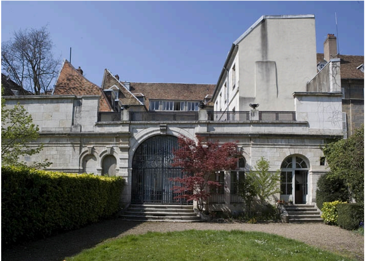
Vue de la façade postérieure du jardin d'hiver.
