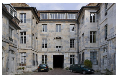
Vue d'ensemble des façades sur cour du logis principal depuis le fond de la cour. Phot. Yves Sancey IVR43_20072500253NUCA
