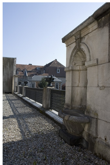
Vue de la borne fontaine sur la terrasse du jardin d'hiver. Phot. Yves Sancey IVR43_20072500243NUCA
