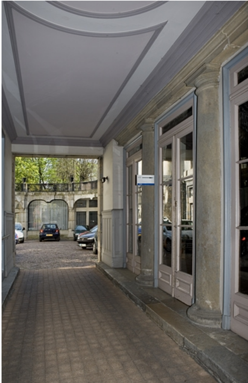
Vue d'ensemble du passage cocher depuis l'entrée.
