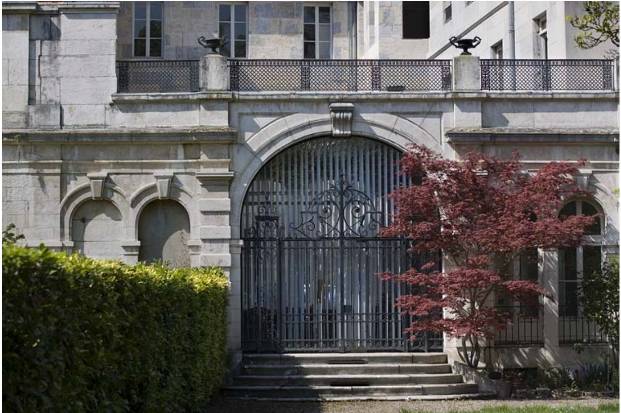
Détail de la façade postérieure du jardin d'hiver.
