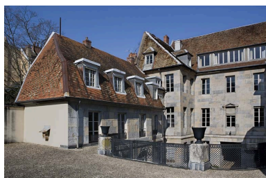
Vue de l'aile droite sur cour depuis la terrasse du jardin d'hiver. Phot. Yves Sancey IVR43_20072500239NUCA
