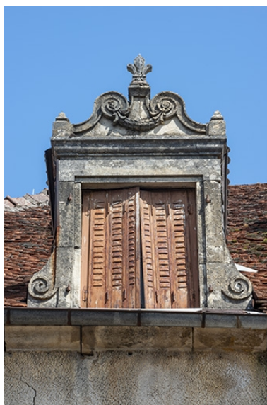
Détail de la lucarne gauche. Phot. Jérôme Mongreville IVR43_20217000531NUC4A
