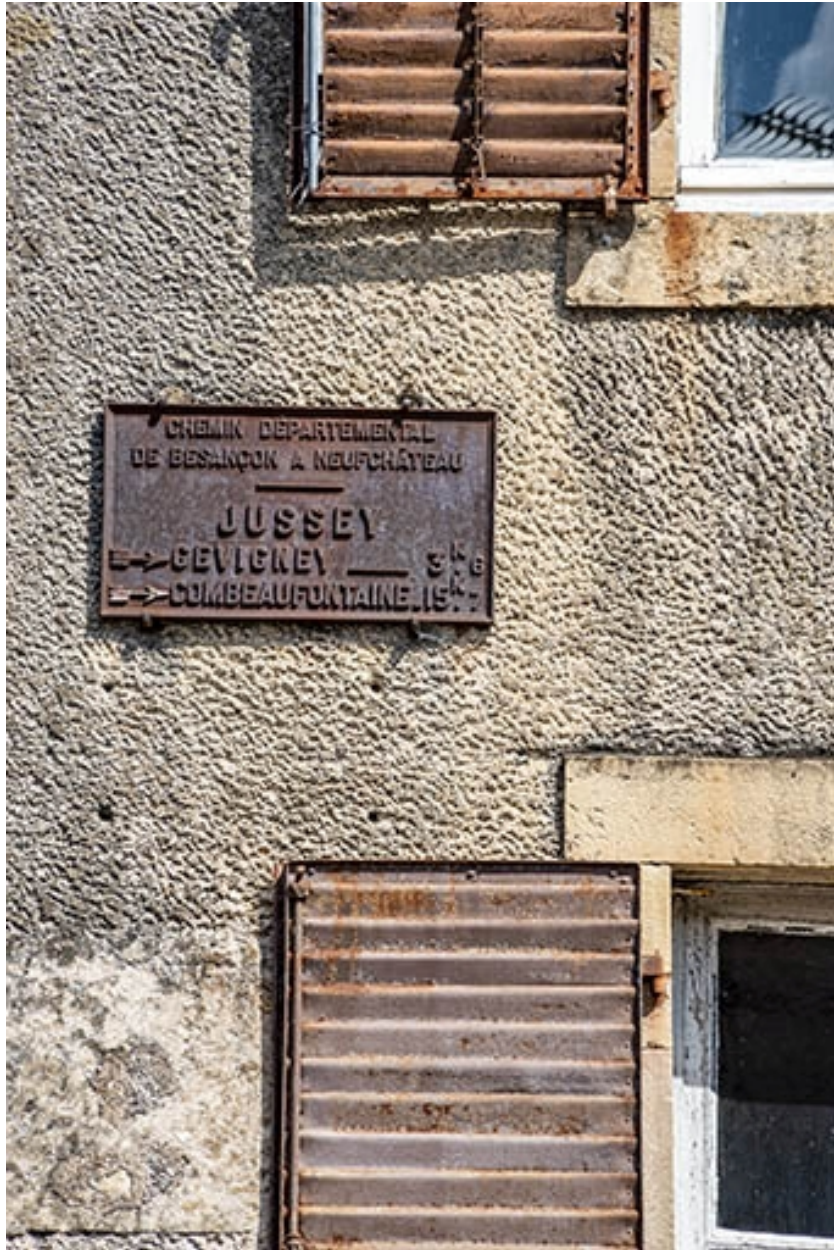
Détail de la façade avec plaque directionnelle.
