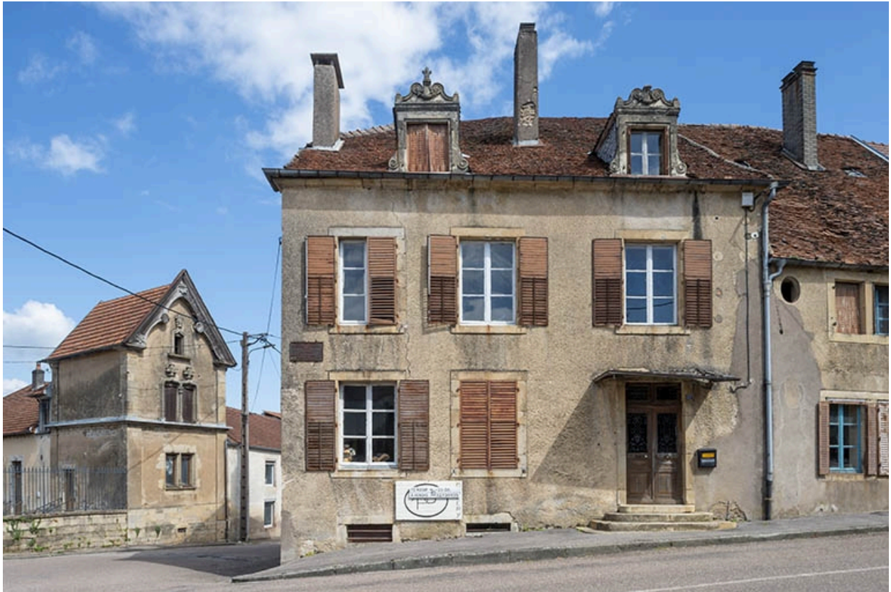
Façade antérieure de la maison.
