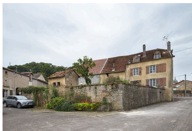
L'arrière de la maison. Phot. Jérôme Mongreville IVR43_20217000535NUC4A
