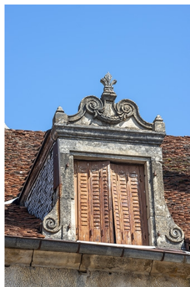
Détail de la lucarne droite. Phot. Jérôme Mongreville IVR43_20217000532NUC4A
