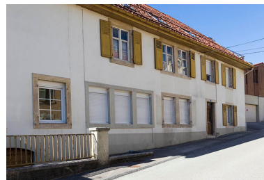
Ferme : façade antérieure, de trois quarts gauche.
