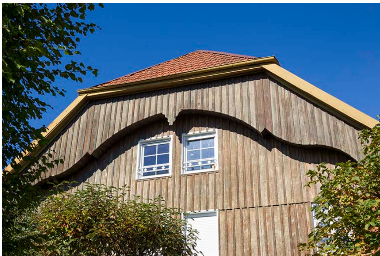
Ferme, façade latérale gauche : lambrichure et rang-pendu.
