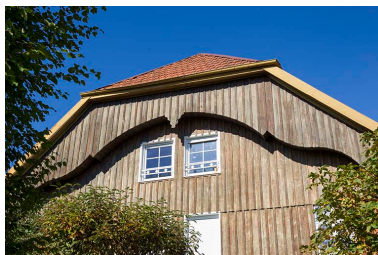
Ferme, façade latérale gauche : lambrichure et rang-pendu.
