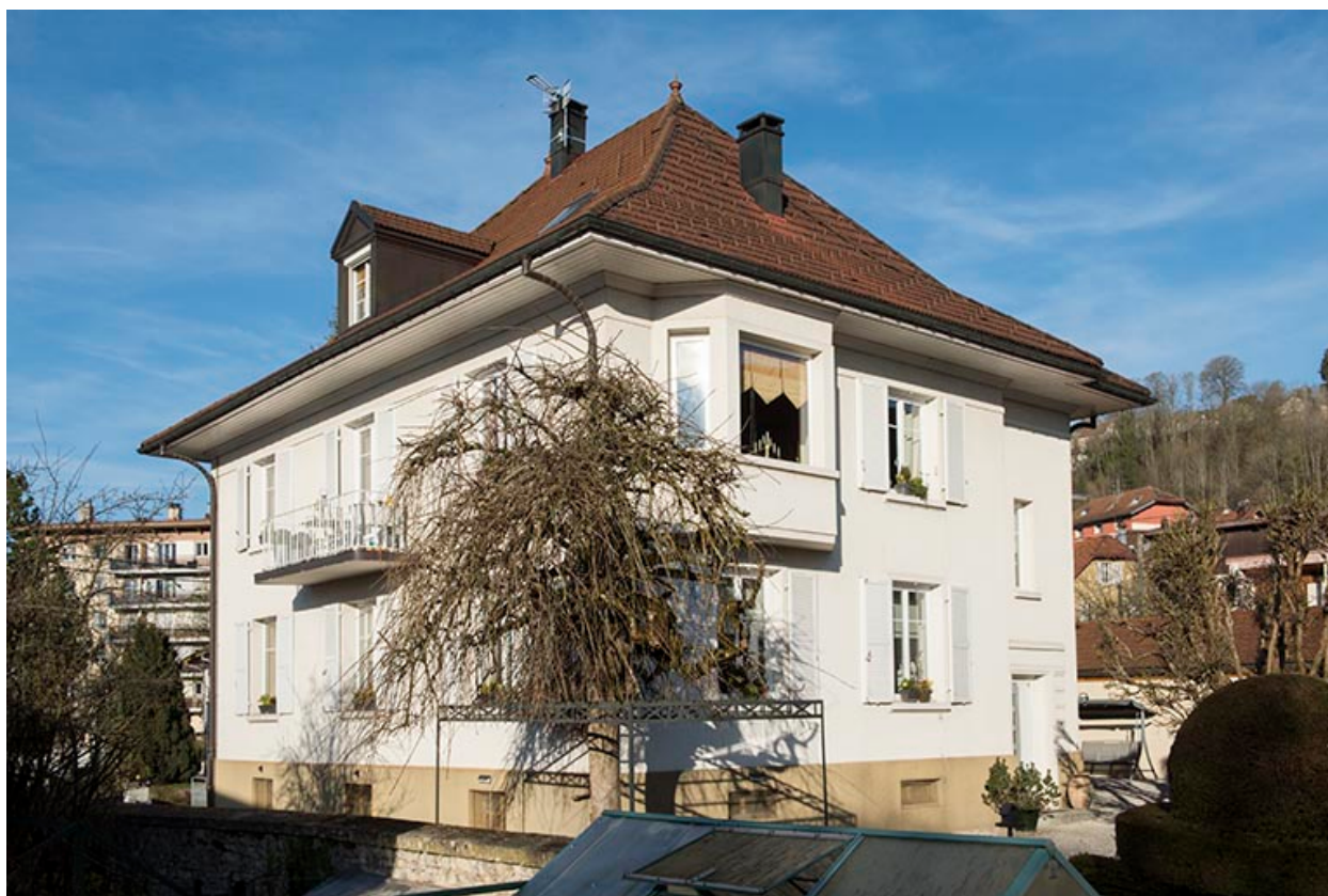
Maison-usine : élévations sud-est et nord-est.
